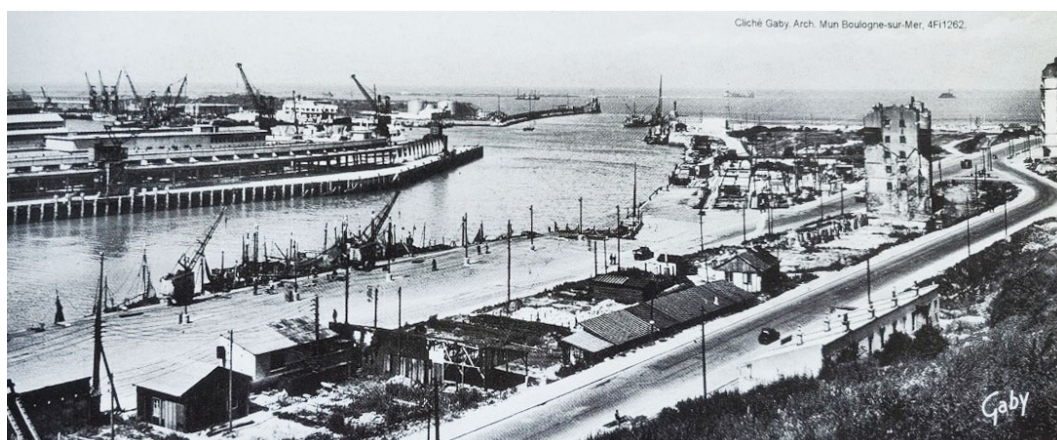
24 : Le nouveau port, face au quai Gambetta qui attend la reconstruction.
