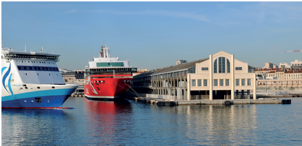
44 : Réhabilitation du Hangar J1 à Marseille / Reichen & Robert.
