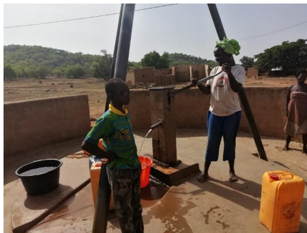
Image 1 : Forage équipé d'une pompe à motricité humaine (PMH)
