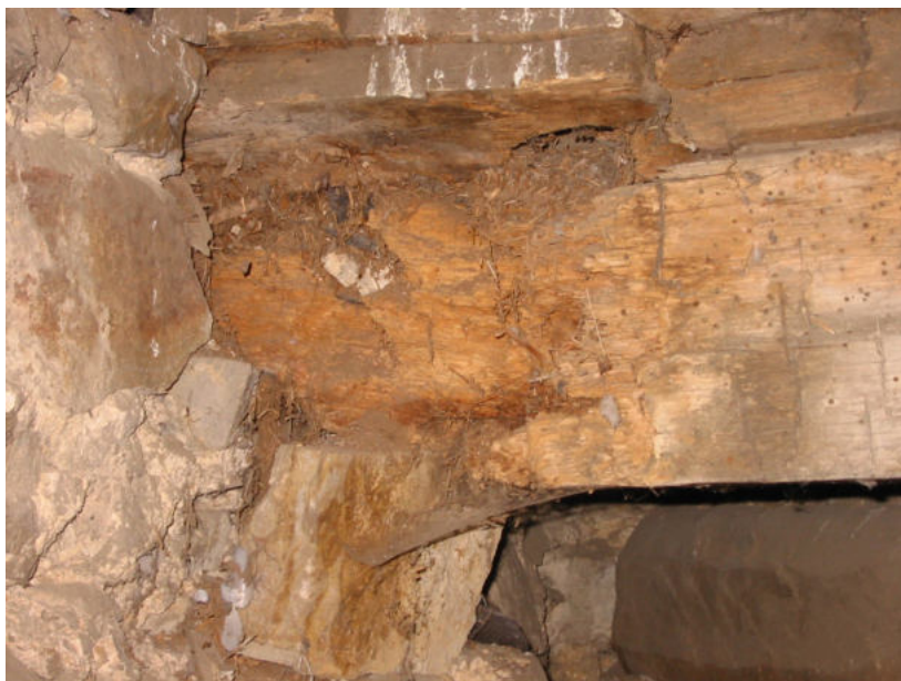
Fig. 128 About d'un entrail de la charpente du chœur. Source JACQUES, Yves. Etude préliminaire de stabilité. Chapelle Templière de Haneffe. Rapport de stabilité F146. 2009.
