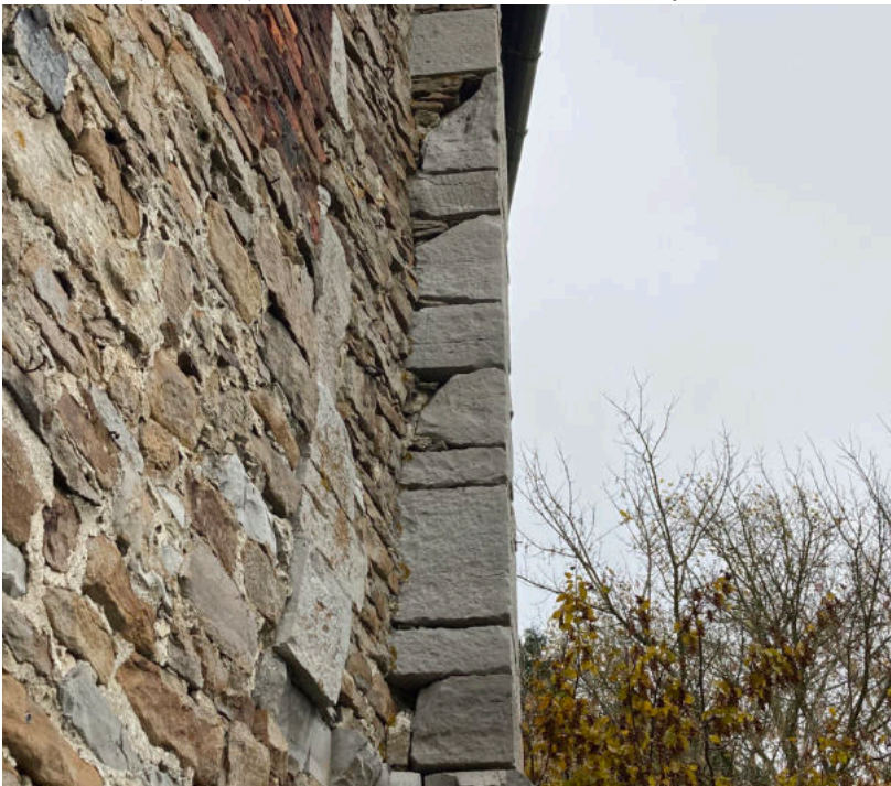
Fig. 53 US.01.003. Emploi de calcaires de Meuse cassés. CdA (20.11.2021).
