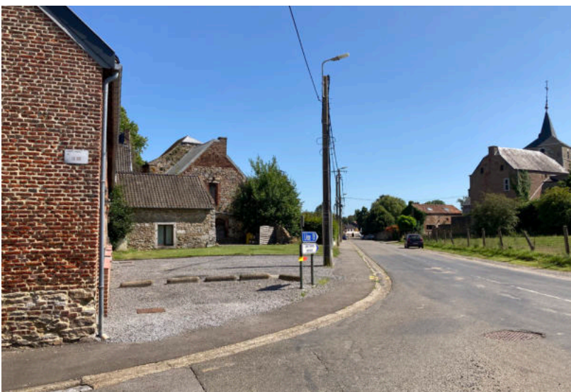
Fig. 2 Vue depuis la rue La Rue. A gauche, extrémité de la commanderie ; en arrière plan, façade ouest de la chapelle des templiers ; à droite, l'église Saint-Pierre. CdA (14.08.2021).
