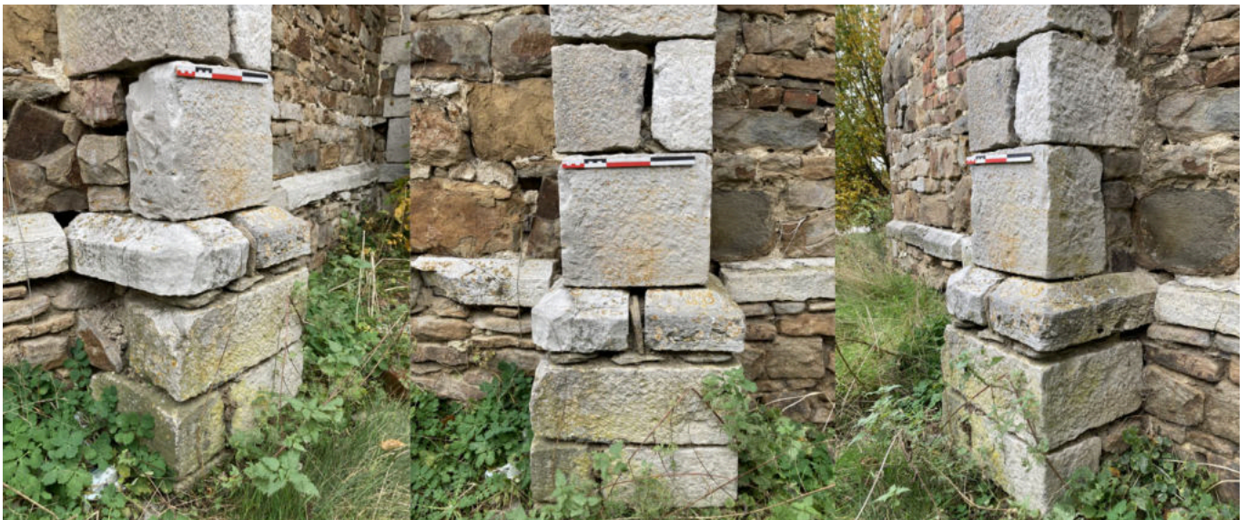
Fig. 52 US.01.003. Finitions du calcaire de Meuse. A gauche, face clivée ; à droite, face taillée. CdA (20.11.2021).
