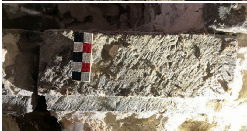
Fig. 72 US.01.060. Taille pointée à la broche sur l'appui en calcaire de Meuse de la niche.
