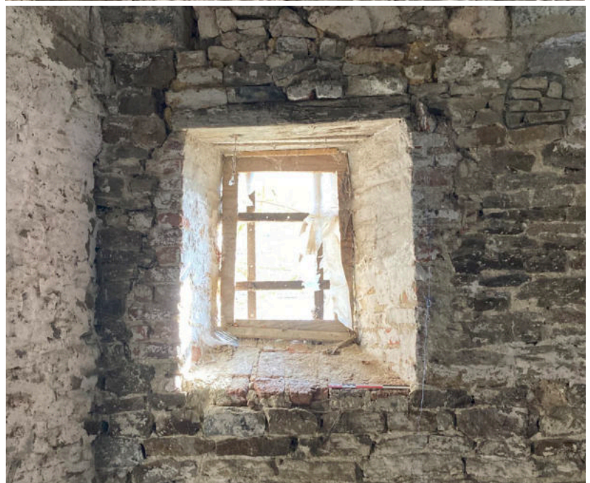
Fig. 65 US.01.045. Baie nord avec linteau intérieur en pierre.
