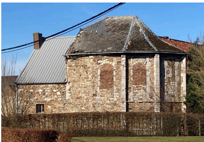
Fig. 38 Façade sud de la chapelle. CdA (13.02.2021).
