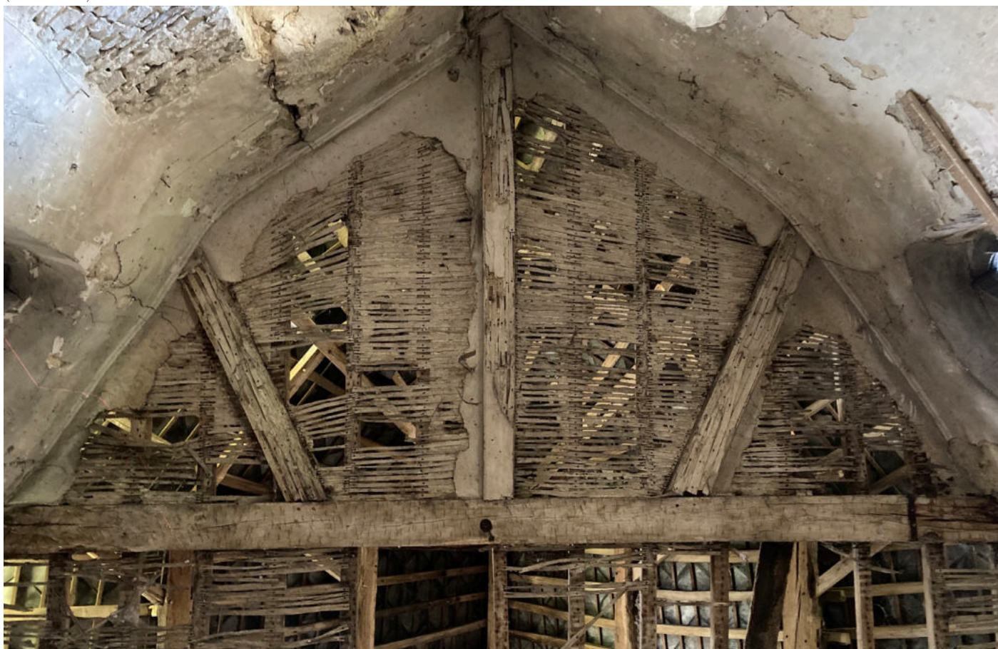
Fig. 129 Lattis de la charpente du chœur. CdA (13.03.2022).
