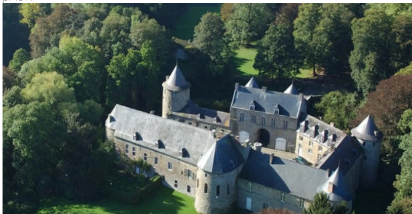
Fig. 50 Corroy-le-Château. A gauche : chapelle dans une tour semi-circulaire du château de Corroy-le-château (Gembloux). Source PATRIVIA. Château de Corroy le Château. < https://patrivia.net/visit/namur-chateau-de-corroy-le-chateau > ; A droite : plan du château. Source BRAGARD, Philippe. Essai sur la diffusion du château « philippin » dans les principautés lotharingiennes au XIIIe siècle. In: Bulletin Monumental , tome 157, n°2. Lyon : Persée, 1999. p. 159.
