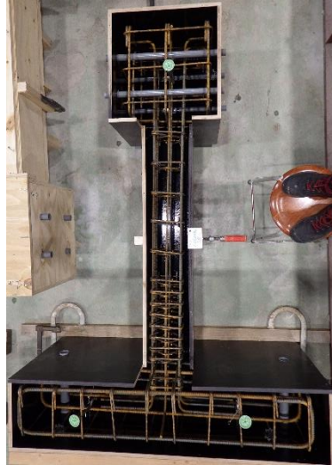
Figure 27 - Coffrage en bois bakélinisé et ferrailage
