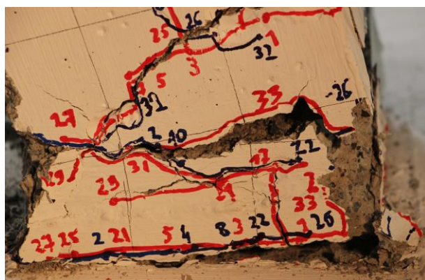
Figure 205 - Fissuration à la base de la colonne C3C lors de la rupture (LS35)
