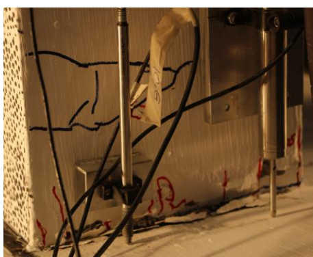
Figure 187 - Fissures verticales de compression sur la face latérale droite de la colonne C2A au LS31
