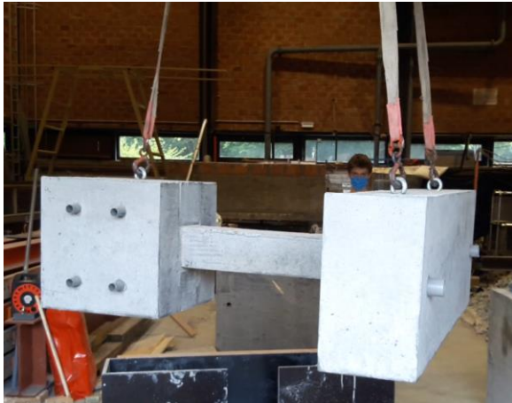
Figure 35 - Soulèvement des colonnes pour le décoffrage
