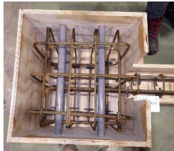
Figure 28 - Réserve dans le coffrage (tubes en PVC)
