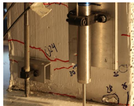
Figure 190 - Fissures verticales de compression sur la face latérale gauche de la colonne C2C au LS32
