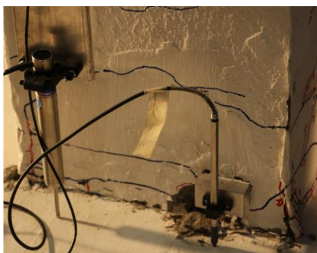
Figure 185 - Fissures verticales de compression sur la face latérale droite de la colonne C1B au LS31
