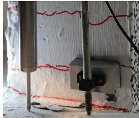
Figure 195 - Fissures verticales de compression sur la face latérale gauche de la colonne C3B au LS32
