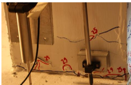
Figure 191 - Fissures verticales de compression sur la face latérale droite de la colonne C2C au LS31
