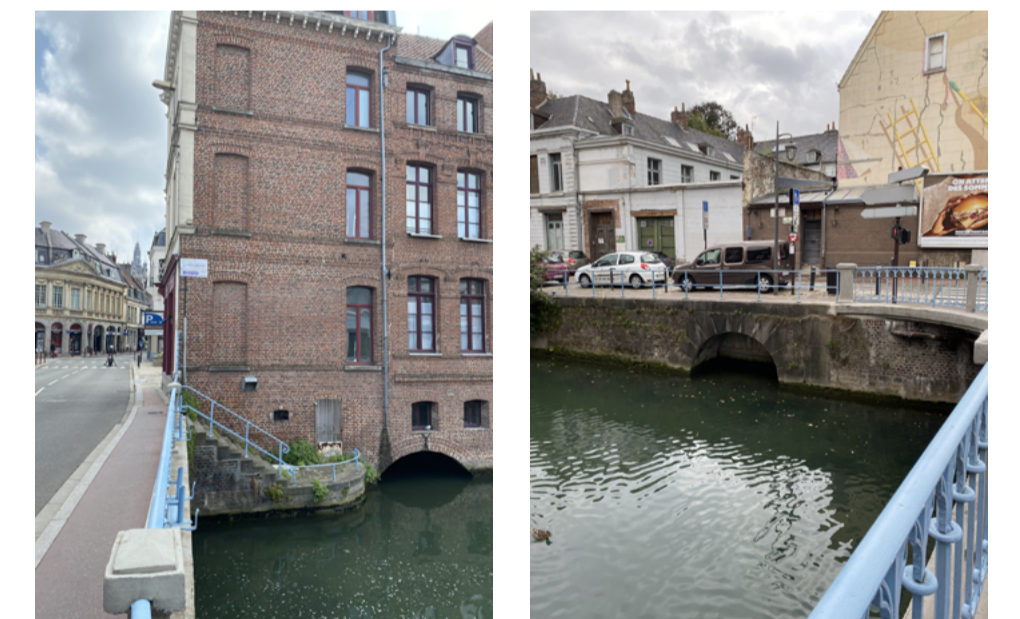
Traces de l'ancien bail. Source : photographie personnelles.
