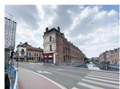
Extrémité du bâtiment - Existant.
