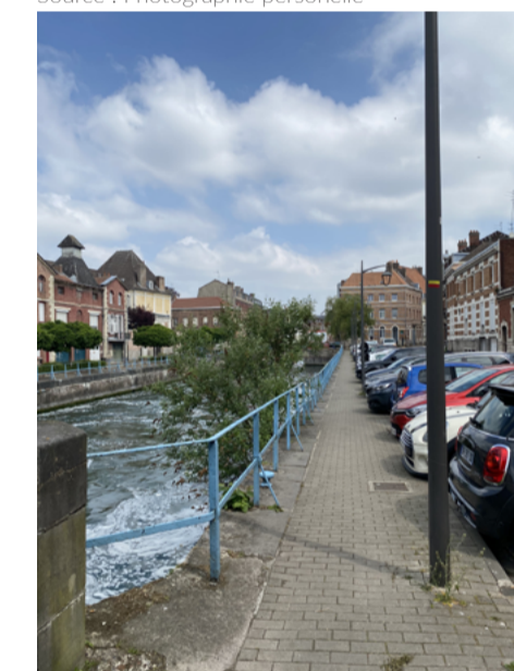
Quai du Maréchal Joffre. Source : Photographie personnelle
