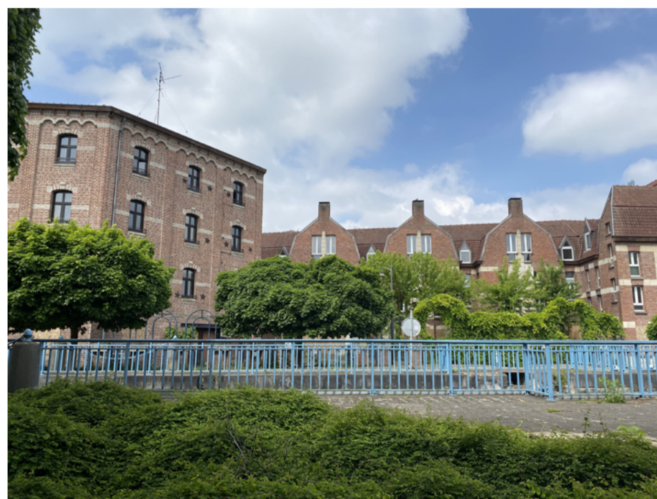
Ancien Moulin des Augustins. Source : Photographie personnelle
