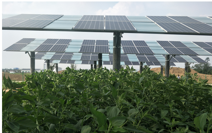
FIGURE 8.1 – Application des diffuseurs à une structure agrivoltaïque, "The Even-lighting Agrivoltaic System", China (Wen Liu)
