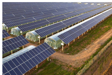
(b) Exemple de serres agrivoltaïques [10].
