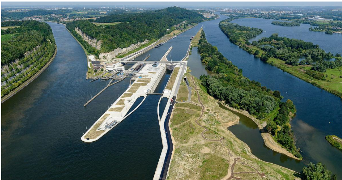
Figure 1-17: Quatrième écluse de Lanaye [20]
