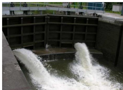
Figure 1-7: Exemple de remplissage par les portes
