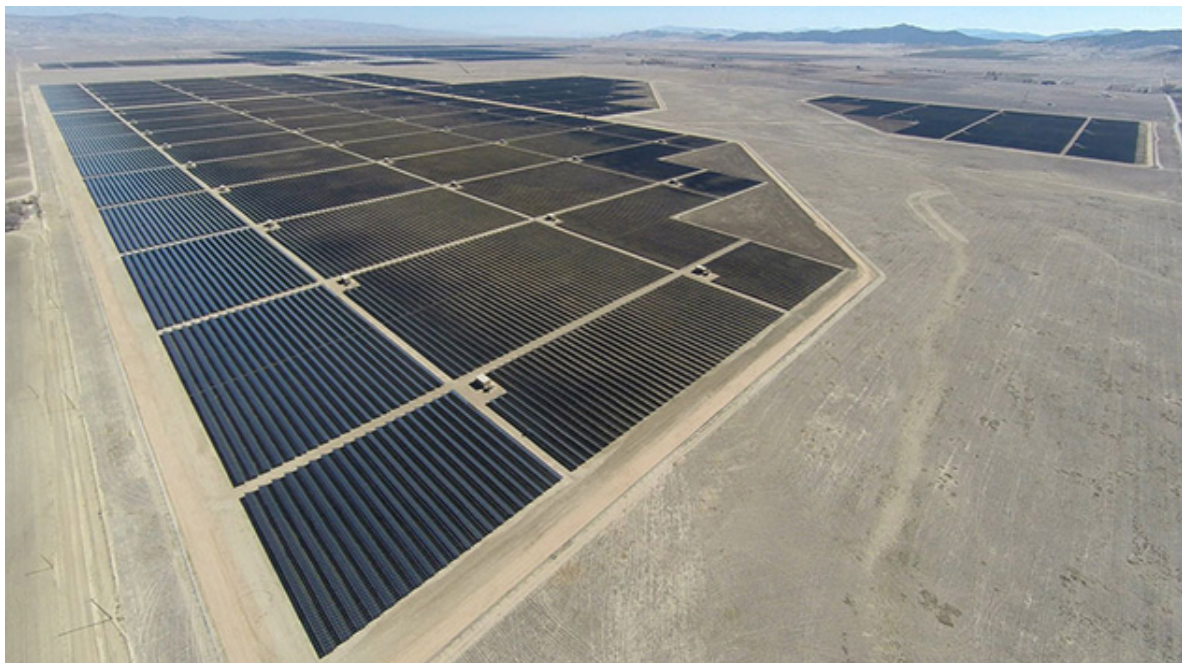
FIGURE 3.1 – Ferme solaire photovoltaïque de Topaz Solar Farm (550 MWc), située en Californie 1
