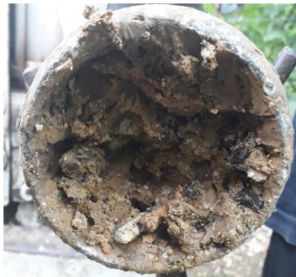
Forage Marnières - Figure 9 : Profil au point F, dans le fond de la gouge. Présence importante de graviers. Photo par Hélène Sosnowski.
