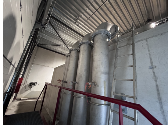
(b) Conduites vues de l'arrière du bassin
