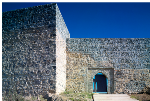
Fig. 57 REPUBLICA DM, Castillo de Cala , 2011 Compléter la ruine en périphérie.
