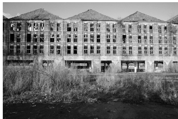
Fig. 43 VANACKER Bart, Les hangars de séchage des Tuileries du Littoral , 2020 Des hangars industriels abandonnés présentent un grand potentiel de réhabilitation.
