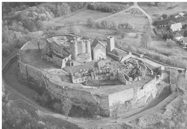
Fig. 80 HLPP, Le Château de Lichtenberg avant l'intervention architecturale L'édifice présentait un état de délabrement avancé.
