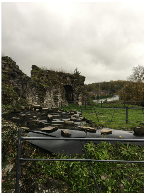
Fig. 96 JACQUEMIN Gilles, Installation de membranes étanches sur la cave de l'habitation du XVII e siècle , 2023
