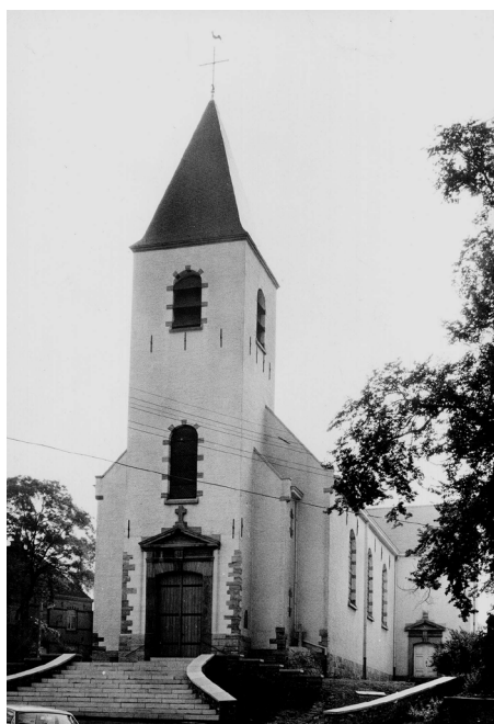
Fig. 85 BALAT, Eglise paroissiale Saint-Pierre , 1978 L'Eglise Saint-Pierre surplombe la place du village.
