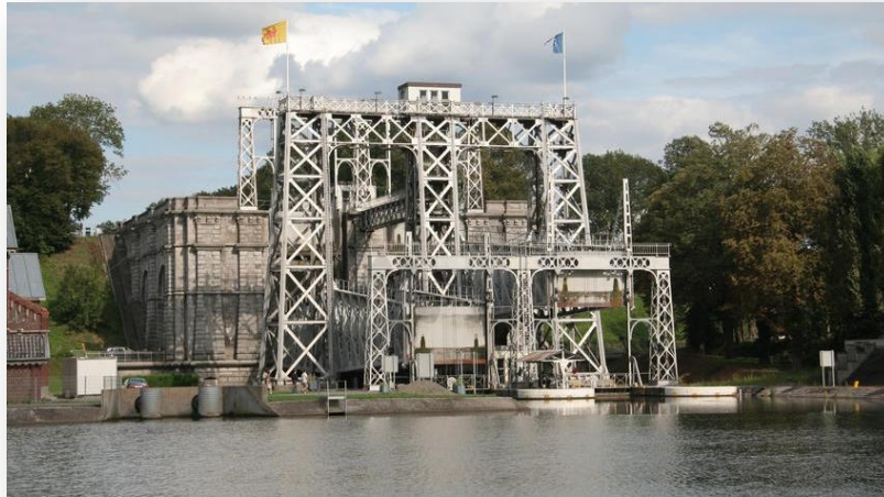
Figure 1 : Ascenseur n°4 de Thieu
