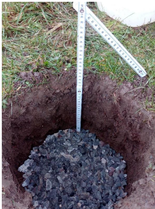
Figure 14 : Mise en place d'un essai Porchet.
