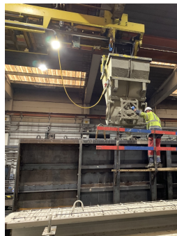
(b) Bétonnage d'une poutre
