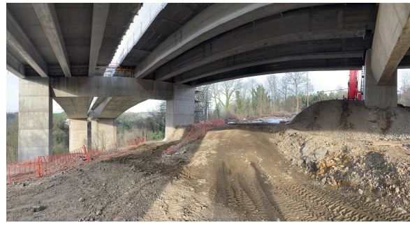
(b) Situation sur chantier en T10
