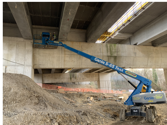
FIGURE 7.6 – Accès à P10 en nacelle
