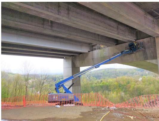
FIGURE 7.5 – Accès à P9 en nacelle
