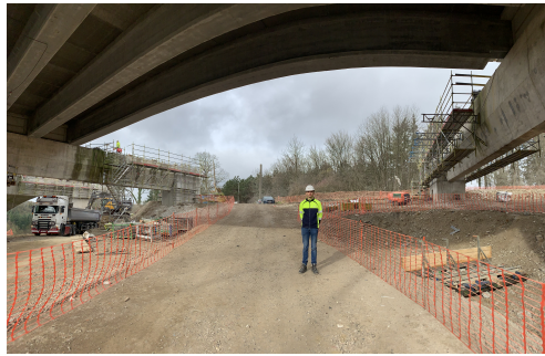
(a) Situation sur chantier en T11
