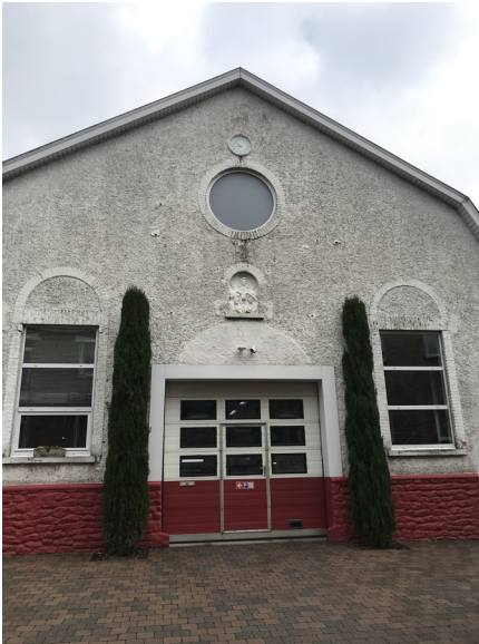
Figure 69 : Façade du garage BCS
