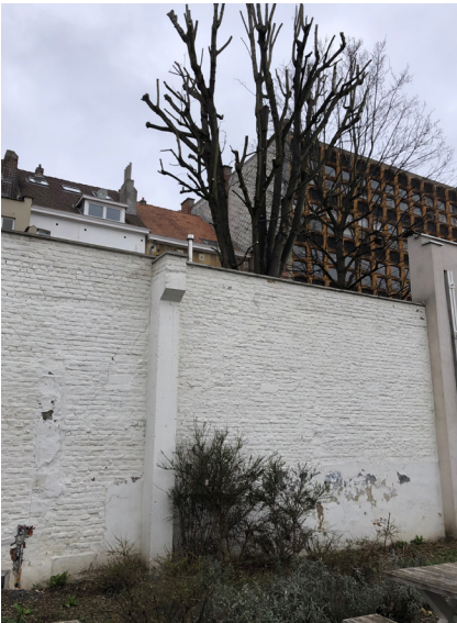
Figure 143 : Un mur mitoyen en intérieur d'îlot
