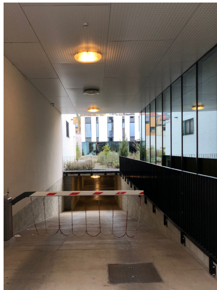
Figure 144 : Accès vers un parking souterrain
