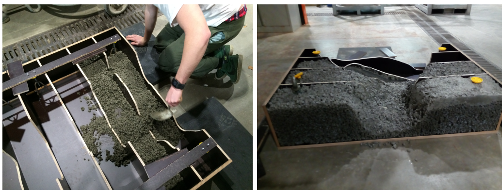
FIGURE 2.7 – Pose du béton
