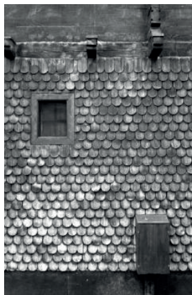
Fig.44 Revêtement bardeaux bois d'une façade de ferme
