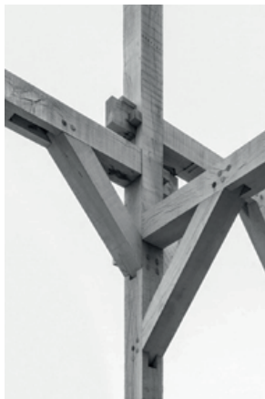
Fig.45 Assemblage structure bois traditionnel
