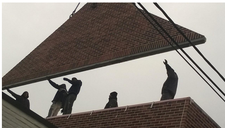
Figure 91 : Pose du pignon
