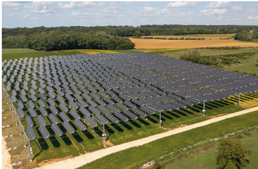
FIGURE 1.11 – Exemple de structure agri-voltaïque [6].
