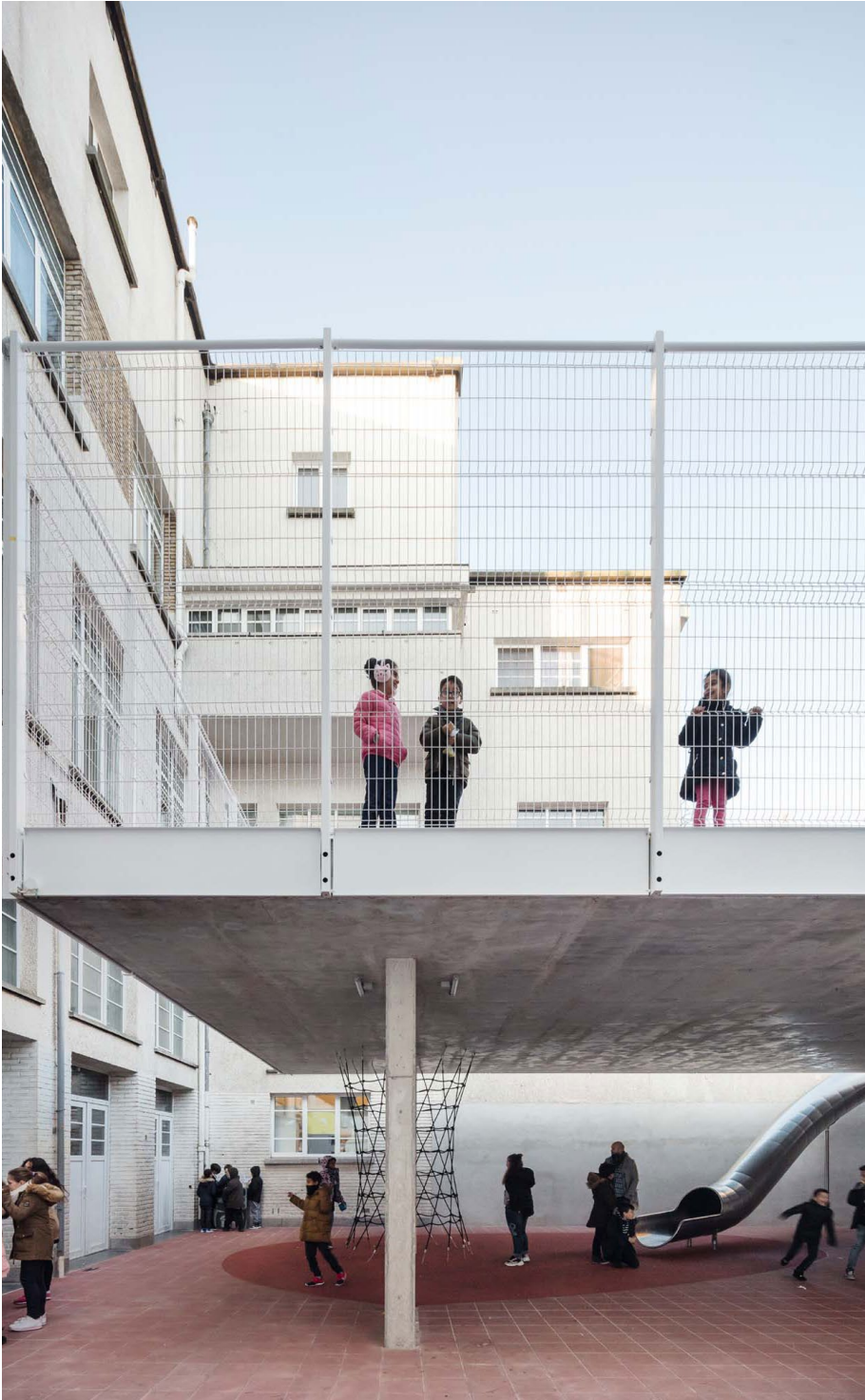
photographie de Stijn Bollaert école à Saint Josse par l'agence Label Architecture qui diversifie dans la cours les activités des enfants
