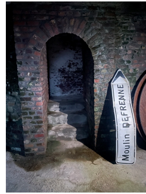
Moisissures sur le mur dû au vent et à l'eau
