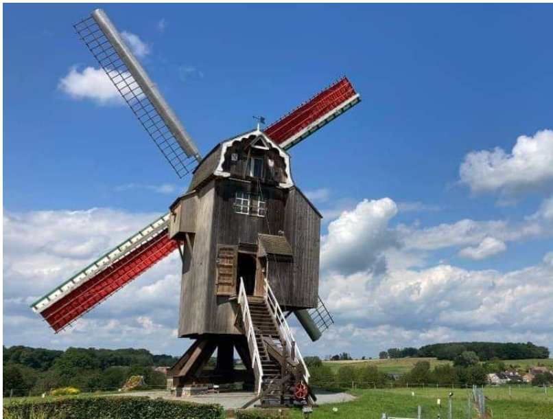
Fig. 63 Inconnu. Moulin de Moulbaix . s.d.
