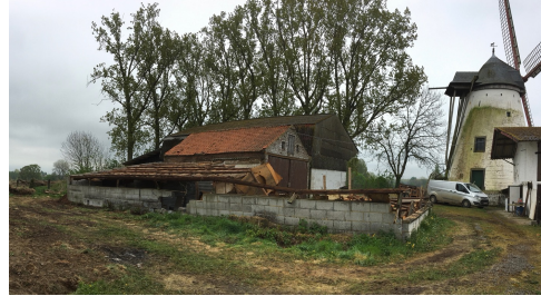
Bâtiment de stockage et atelier
