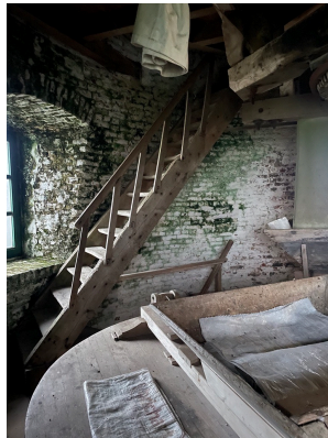
Moisissures sur le mur dû au vent et à l'eau
