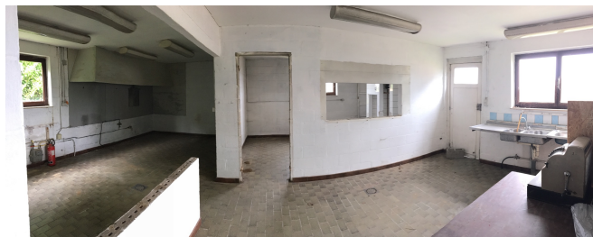
L'intérieur de la cuisine de la salle des fêtes avant chantier.
