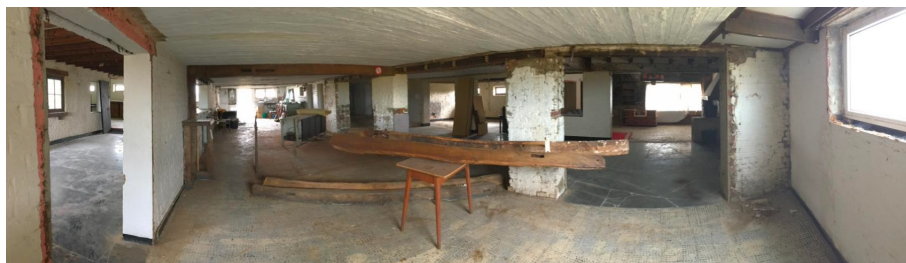
L'intérieur de la maison du meunier pendant chantier.
