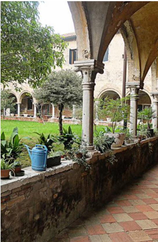
Fig. 50 : Vue sur la cour intérieure du cloître
