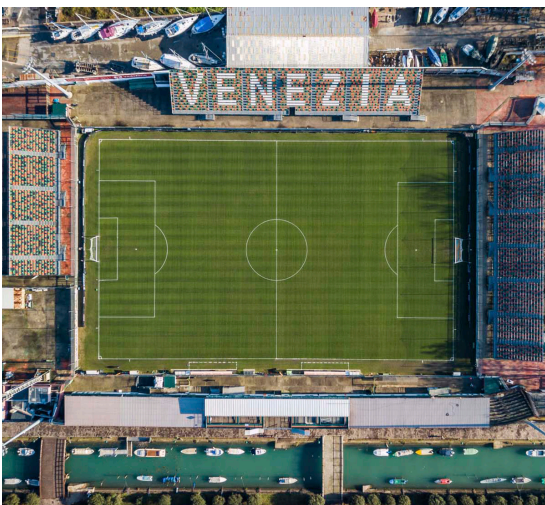
Fig. 56 : Vue aérienne du stade Pierluigi Penzo
