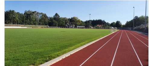
Le club bénéficiera bientôt de la nouvelle piste d'athlétisme de Chimay, qui est en rénovation.
