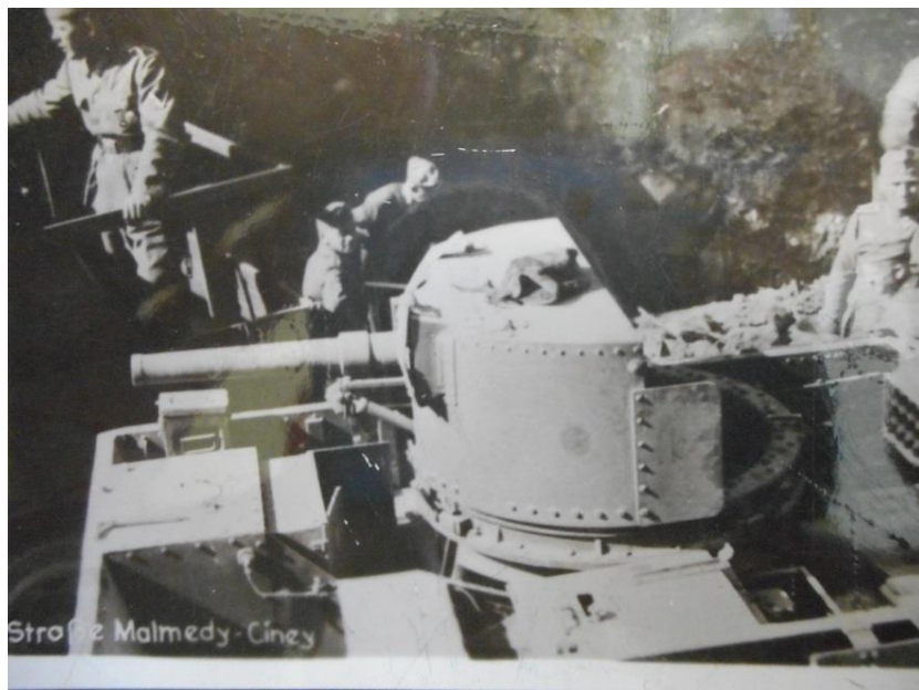
Photo d'un T.13 type I ou II prise en mai 1940 sur la route Malmedy-Ciney. Outre le regard curieux des soldats allemands, on peut remarquer le réservoir d'essence situé à l'arrière du véhicule. (Source : Belgian Tank Museum)
