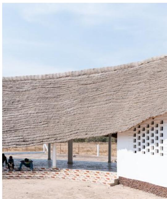
Fig.26 : Toit en Typha, projet Thread Toshiko Mori
