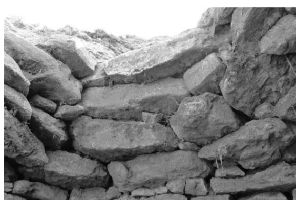
FIG. 32. Volterra. Tumulus delle Colombaie. Vestiges du toit en pseudo-dôme avec les anneaux de dalles en saillie. (ROSSELLI 2015 – 2016, p. 16).
