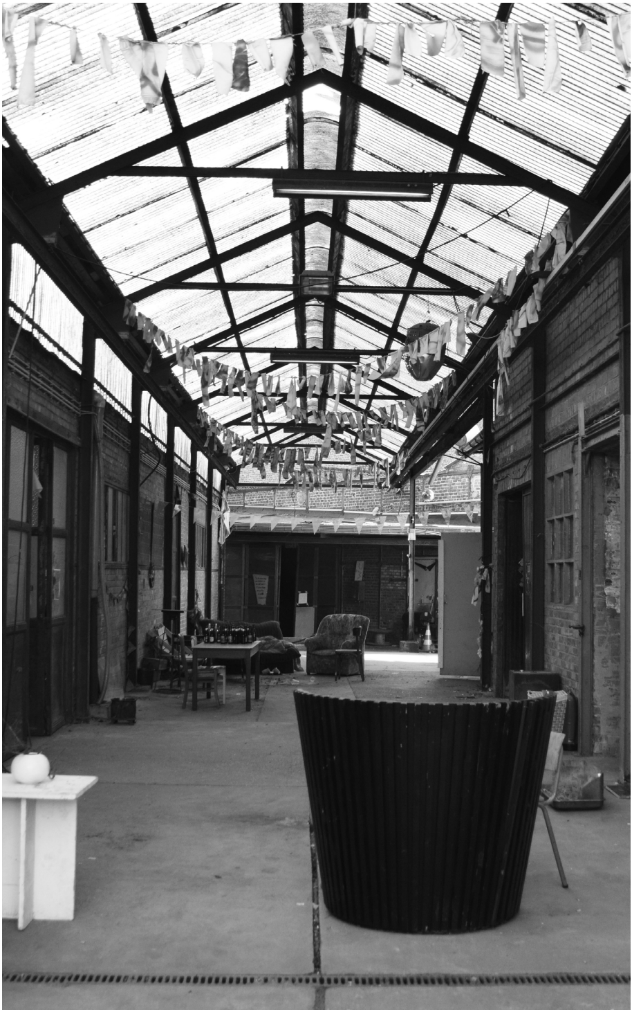
Boissières , Rue intérieure du Zonneklopper, 2022
