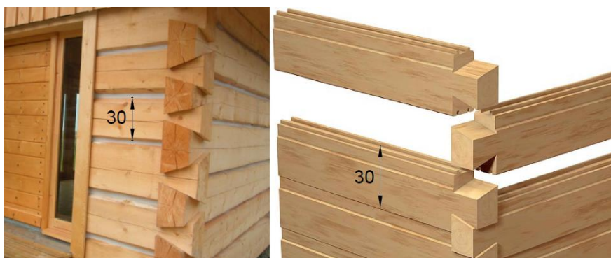
Figure 66 : structure réalisée à l'aide de madriers empilés (dimensions en cm). Le bout des madriers est pourvu de queues d'aronde qui assurant la stabilité de l'empilement. 21
