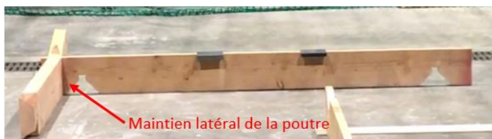
Figure 53 : système de maintien latéral de la poutre ayant été mis en place
