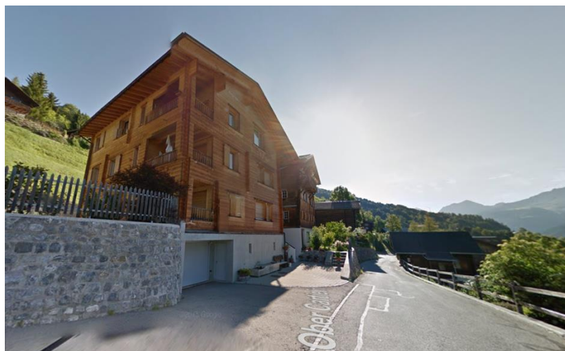
Figure 34 : bâtiment multiétage en bois empilé (Suisse)
