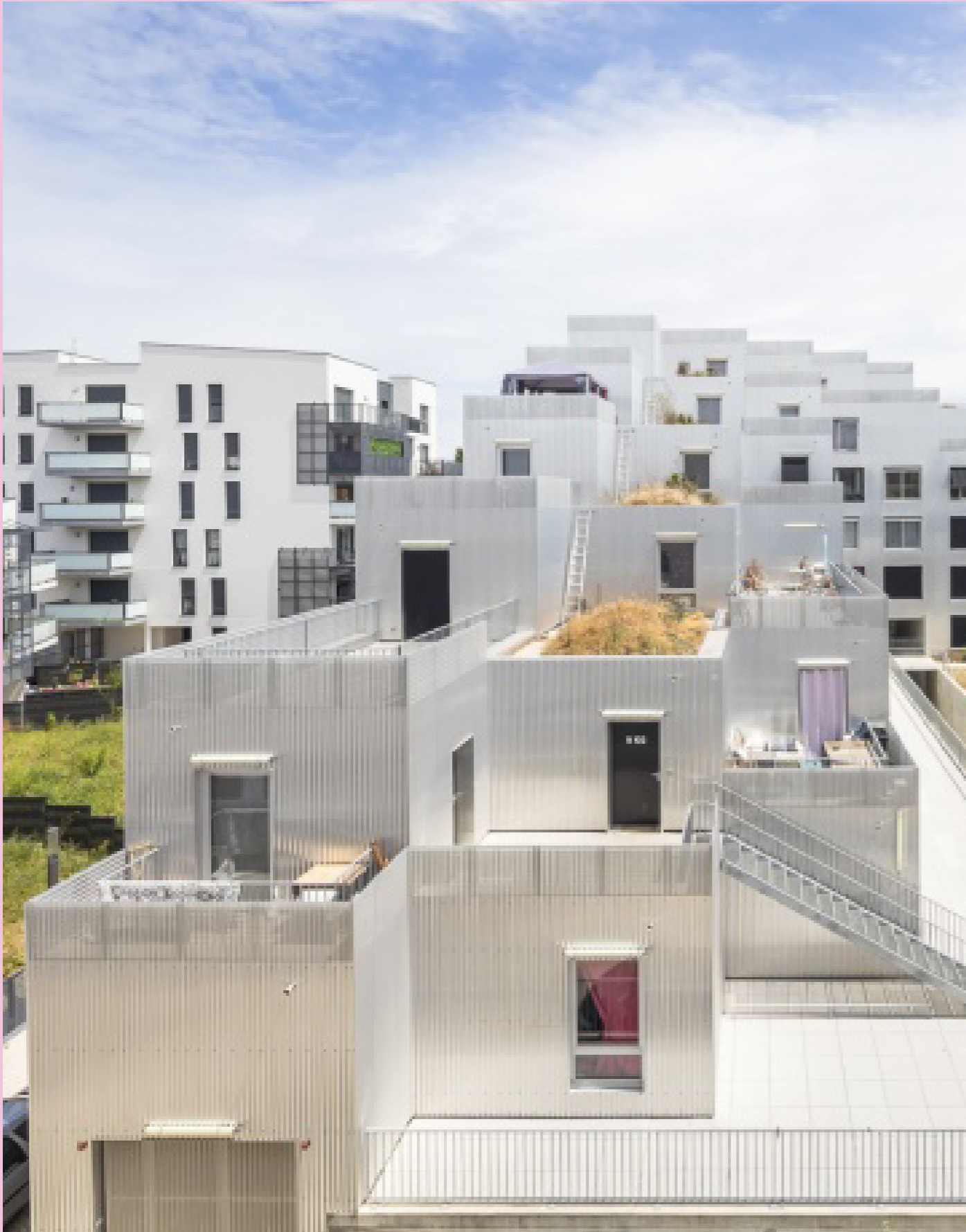
Fig.79 Façade du projet Lov, Dijon
