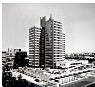
Fig.27 et 28 Service central de la mécanographie et des ensembles électroniques de gestion d'EDF et ensemble administratifs, 1963-1976, J. Renaudie, P. Riboulet, G. Thurmauer, J.L. Véret
