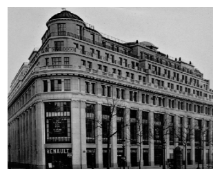
Fig.17 Immeuble de la First Nationale City Bank, 1929-1931, André Arvidson
