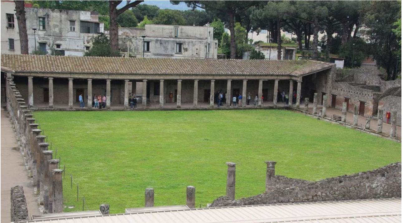
Fig. 19 : Pompéi. Caserne des gladiateurs. Vue depuis le nord. Entre 62 et 79 (HEESE, K., « Caserma dei Gladiatori o Quadriportico del Teatro », in Herculaneum in Pictures , avril 2014, https://pompeiiinpictures.com/pompeiiinpictures/R8/8%2007%2016%20p1.htm [consulté le 3/12/2020]).
