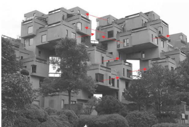
Figure 45 : Photographie du projet Habitat 67 démontrant la disposition des modules (source : theownerbuildernetwork.co )
