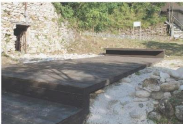
Figure 29 : Photographie d'un exemple d'intervention : la terrasse chœur du couvent Santa Maria delle Grazie (Boissenin, 2020)
