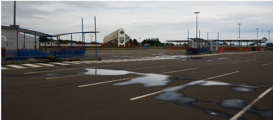
Etage du parking silo
