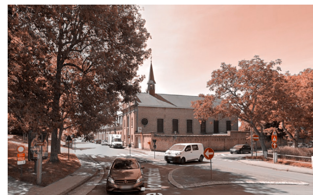
FIG 77 : La maison de retraite classée de l'angle de la ville
