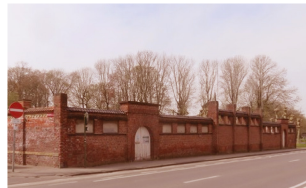
FIG 79 : Le mur de briques qui cerce la piscine à ciel ouvert obstrue les remparts derrière
