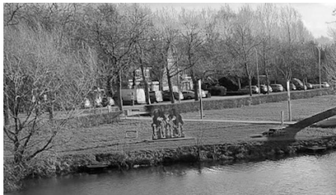
FIG 69 : Le Poternbrug, passerelle piétonne et vélo
