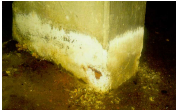
FIGURE 15 – Conséquences des attaques par les sulfates [29]
