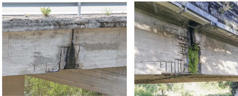
FIGURE 72 – Exemple d'une DEB dans un pont routier [3]
