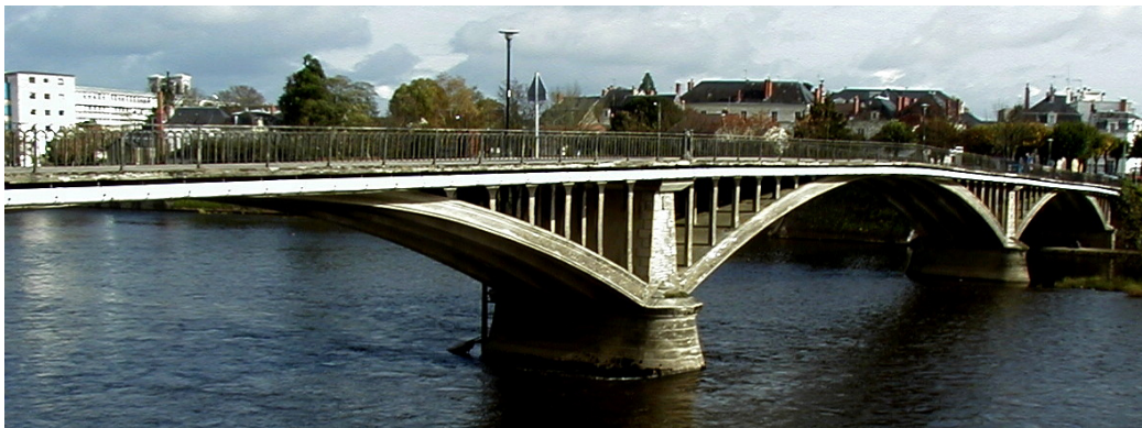
FIGURE 3 – Premier pont en béton armé : Camille-de-Hogues sur la Vienne à Châtellerault [13]
