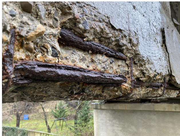
FIGURE 10 – Conséquence de la carbonatation [25]
