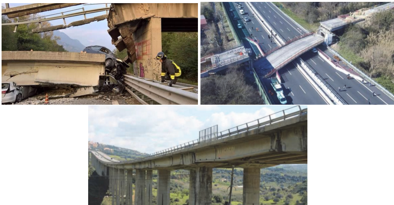
FIGURE 74 – Effondrements de plusieurs ponts routiers (Italie) : Annone [1], Ancona et Akragas [5]
