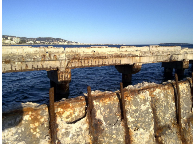
FIGURE 13 – Conséquence de l'attaque des ions chlorure en milieu marin (Cannes) [85]
