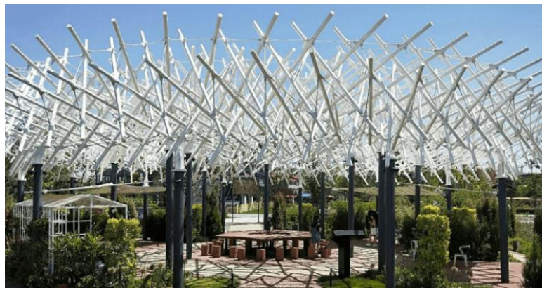
Figure 1 – Structure en tensegrité – jardin belge de l'Expo 2019 à Pékin [3]
