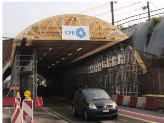
Illustration 57. Panneau avec logo CFE sur le coffrage d'un futur pont 123
