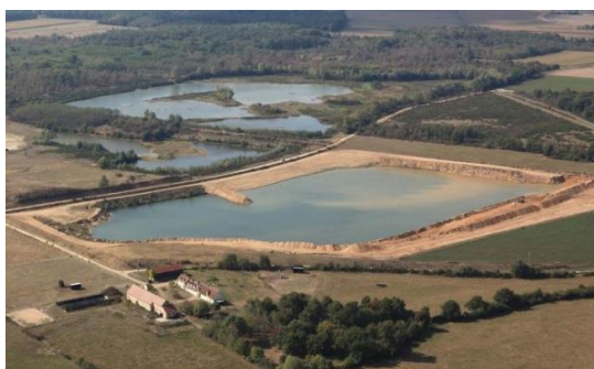
Figure 3 : Bassins de décantation utilisés dans une carrière de granulats
