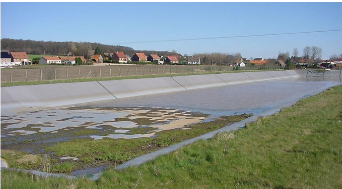
Figure 1 : Bassin de rétention près du village d'Heuringhem en France
