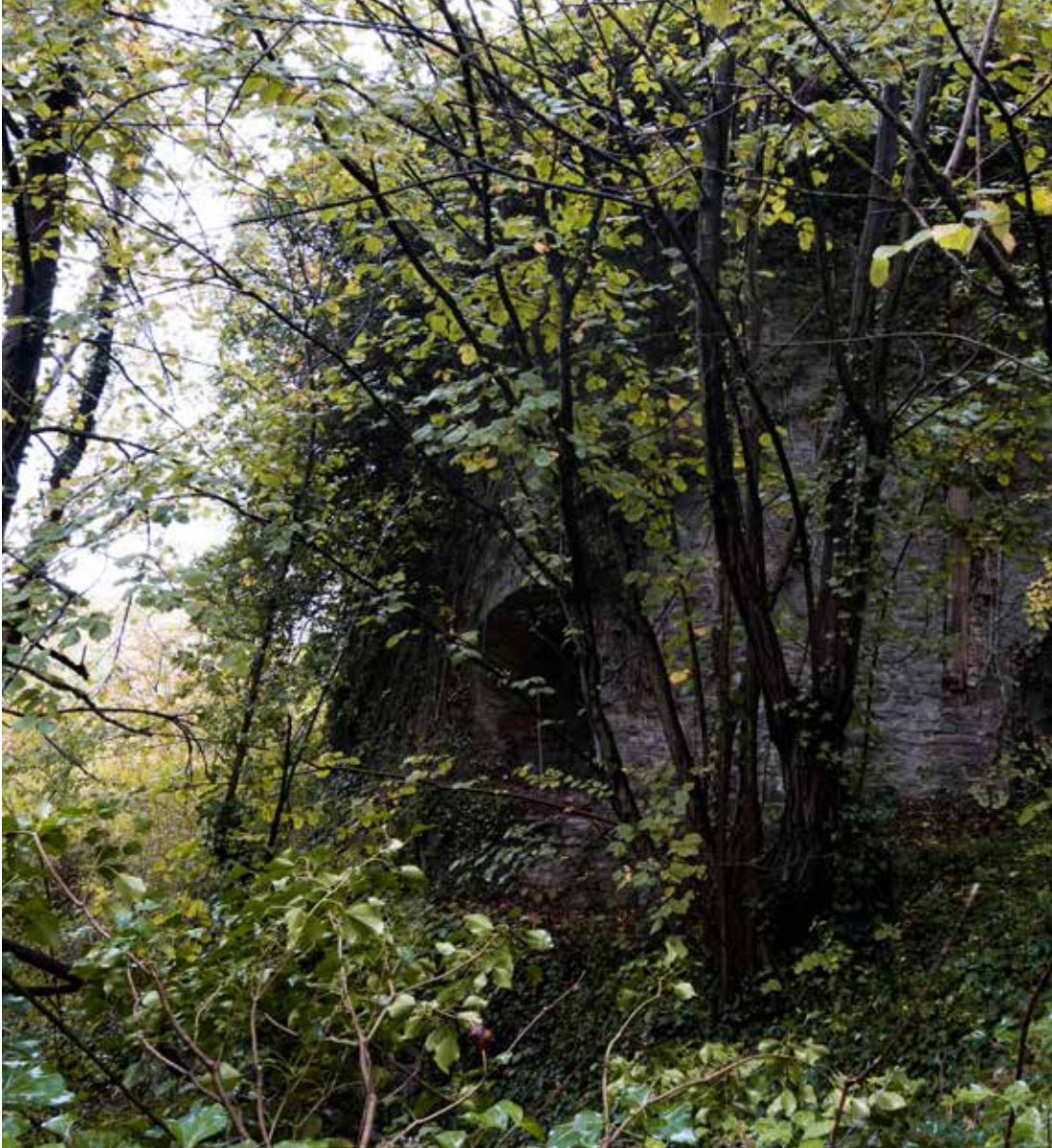
52. Four circulaire façade.
