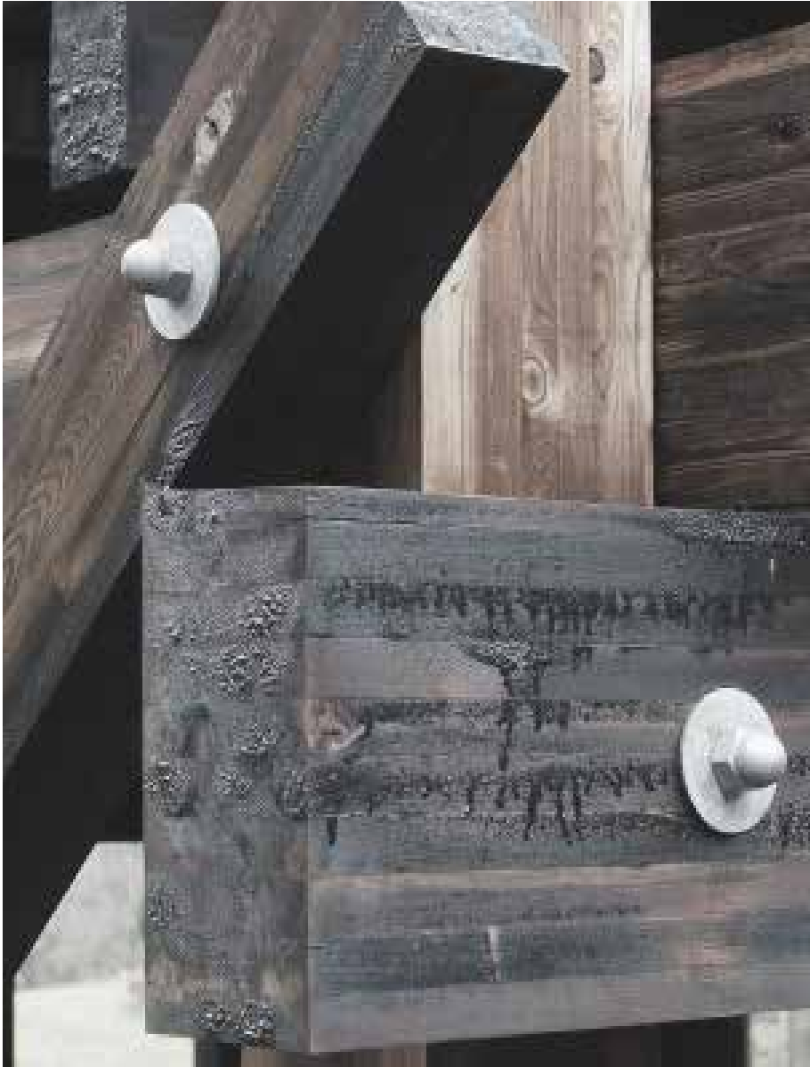
67. Structure des pavillons sur pilotis.
