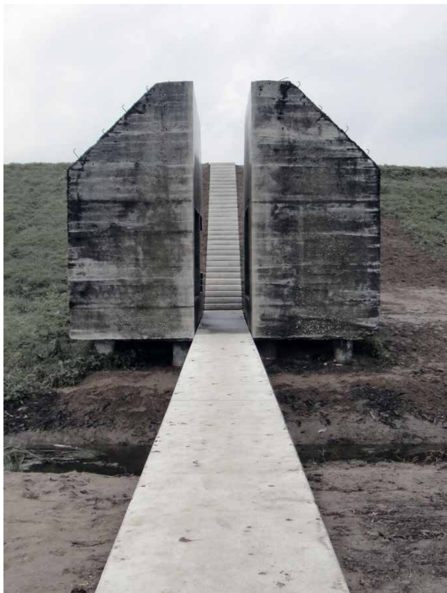
71. Vue de la traversée du bunker.
