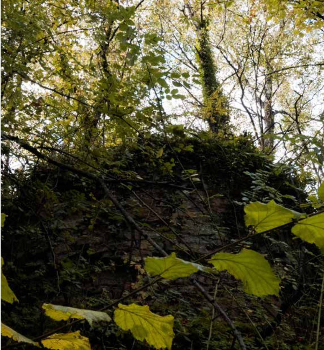
56. Bâtiment du treuil au sommet du massif F.
