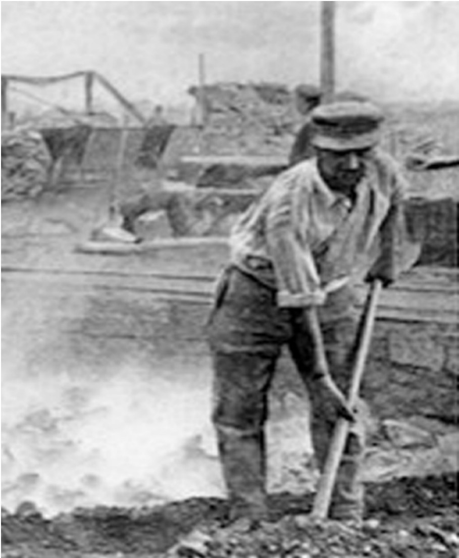
24. Chauffournier chargeant le four en pierre et en coke.
