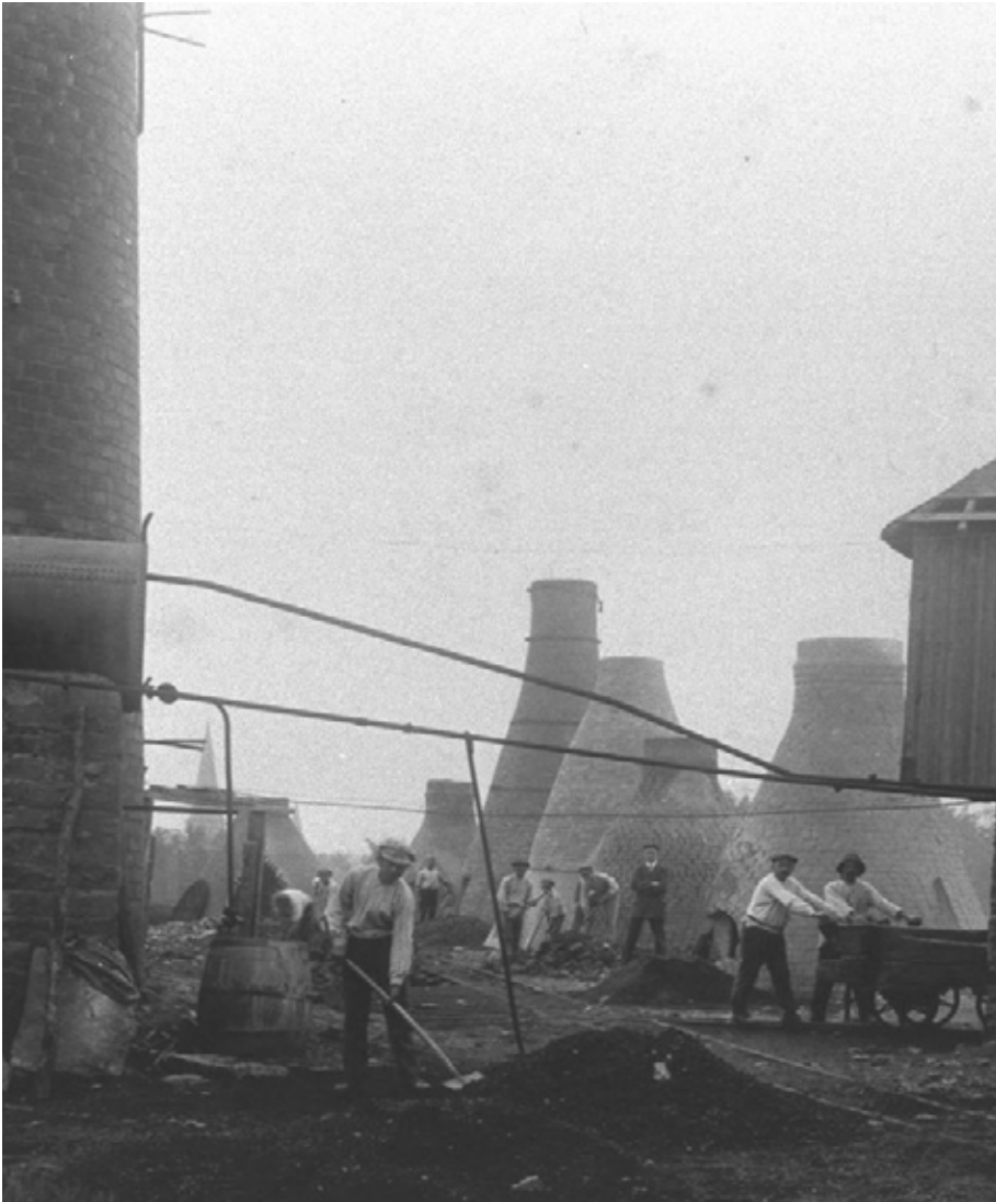
25. Terrasse d'enfournement des fours Joassin à Antoing. A l'arrière, les cheminées de fours « bouteilles».
