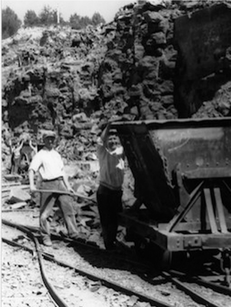
17. Ouvrier chargeant les wagonnets des pierres qui seront cuites dans les fours à chaux;
