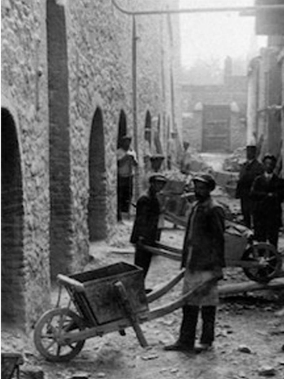
18. Défourneurs déchargeant les produits cuits des fours Joassin à Antoing.
