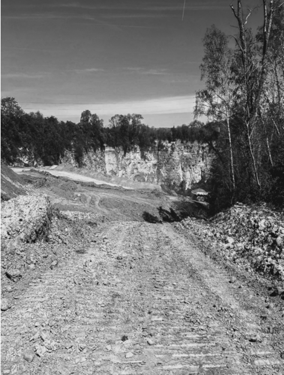
41. Photo prise sur le chantier rive gauche
