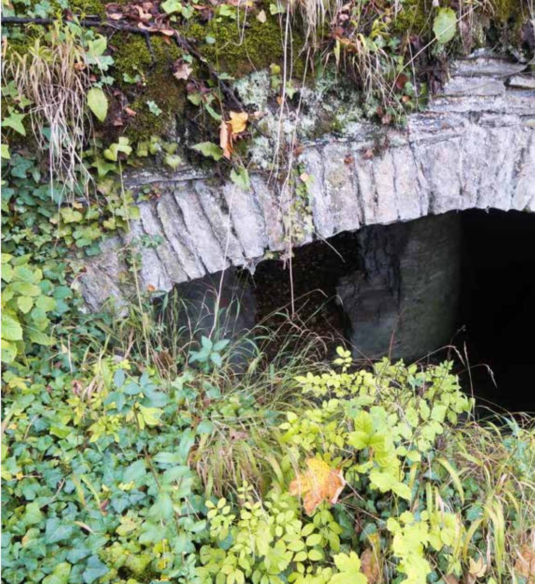
55. Entrée présentant un arch subaissé.
