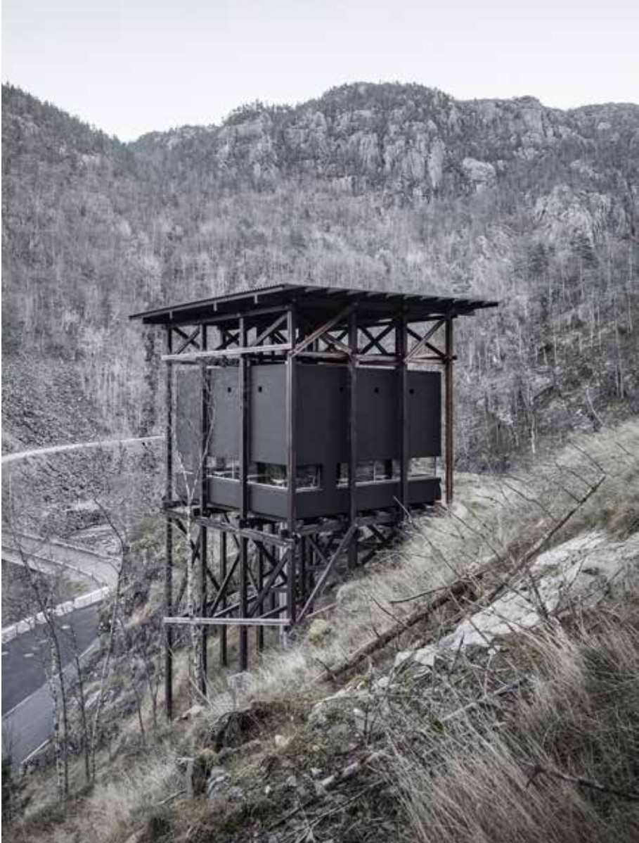
63. Bâtiment de restauration.
