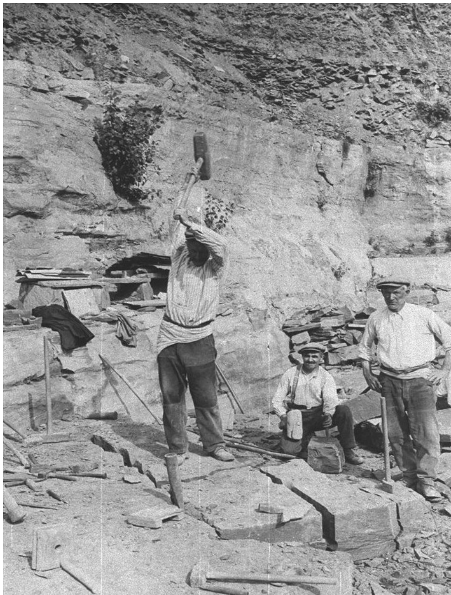
20. Rompeur détachant un bloc de pierre à la masse.
