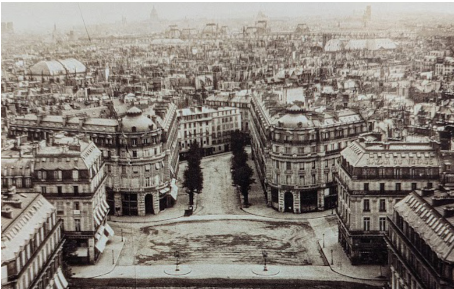
Figure 20 La place de l'Opéra depuis les toits de l'édifice avant la percée de l'avenue de l'Opéra (1870)
