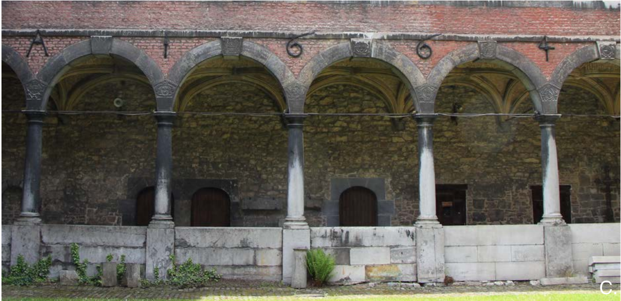
Ancre de la façade de l'aile occidentale donnant sur le cloître formant le millésime A1664.
