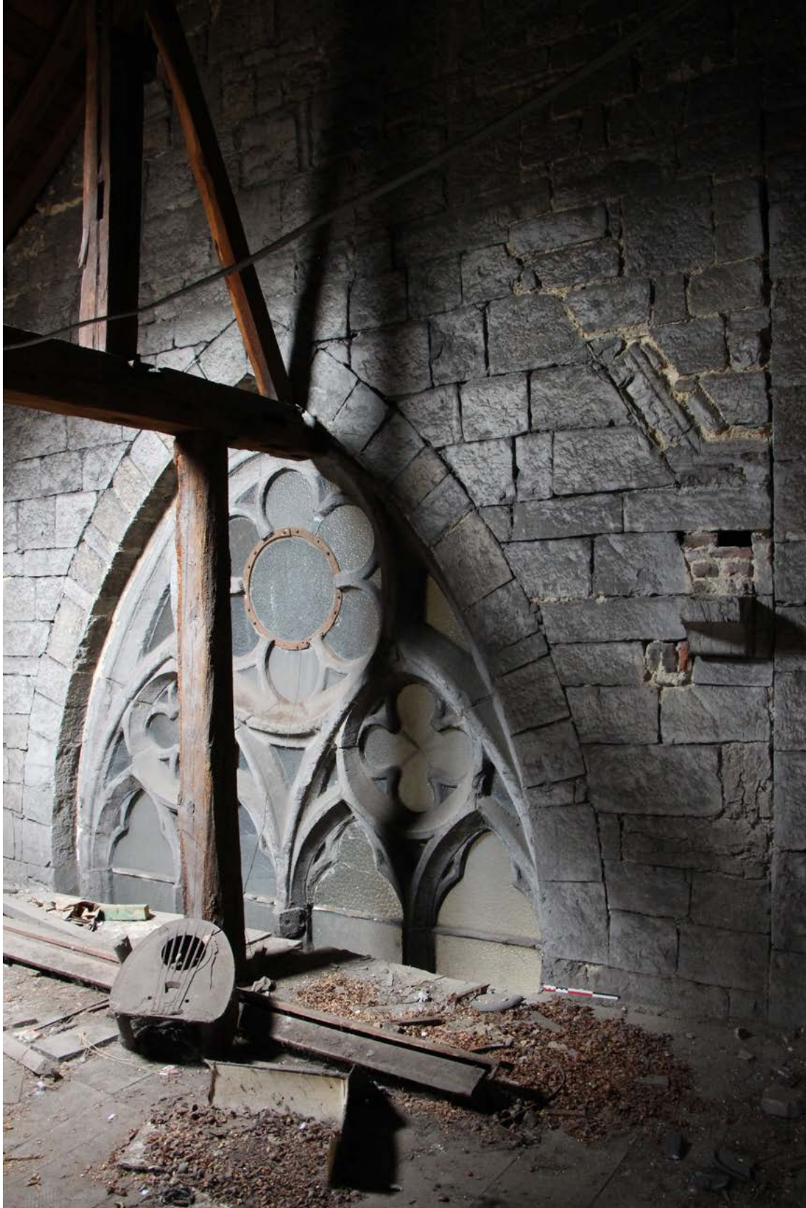
FIGURE 70 Façade occidentale du collatéral nord de l'église. La baie qui l'éclaire généreusement a été relevée et confrontée à une rapide analyse métrologique. Photographie : M. Vanel, mai 2024.
