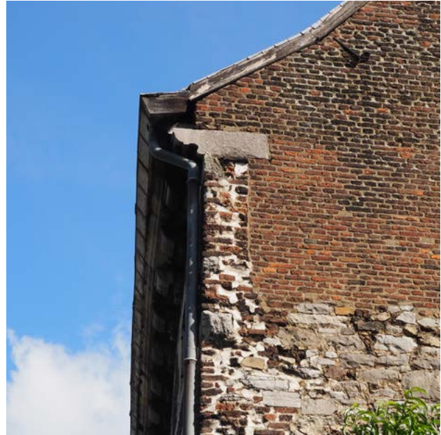
FIGURE 126 Le mur occidental dépasse du nu du pignon (US.41). Corbeau affleurant en partie haute (US.42). Photographie : M. Vanel, juillet 2020.
