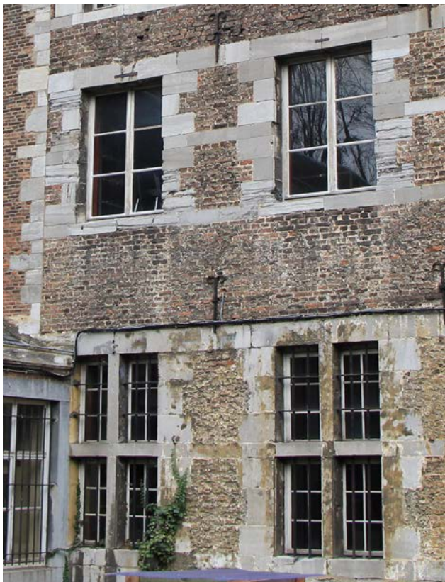
FIGURE 118 Baies du rez-de-chaussée (US.23) et de l'étage (US.25) de la façade sud de l'aile méridionale (2 travées de la zone d'étude). Photographie : M.Vanel, décembre 2020.
