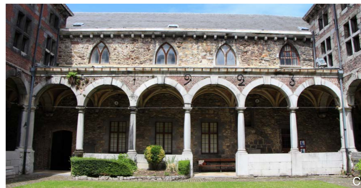
L'élévation méridionale de l'ancienne église, côté cloître, mai 2021.
