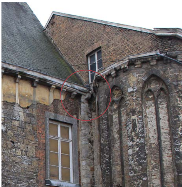
FIGURE 58 On distingue encore une partie du mur de l'église primitive, coincé ente l'absidiole du collatéral nord et le chœur de l'église. Photographie : M.Vanel, décembre 2020.
