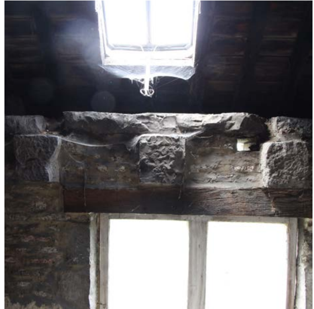
FIGURE 117 Face intérieure des corbeaux en pierre. Photographie : M.Vanel, juin 2022.
