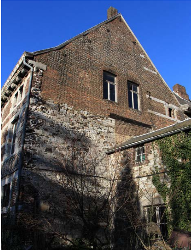
FIGURE 127 Façade pignon M.03/04.F.01, avec une maçonnerie mixte de pierre (US.40) qui s'arrête en dessous du linteau en bois de la baie (US.36). Corbeau affleurant en partie haute (US.42). Photographie : M. Vanel, mars 2021.
