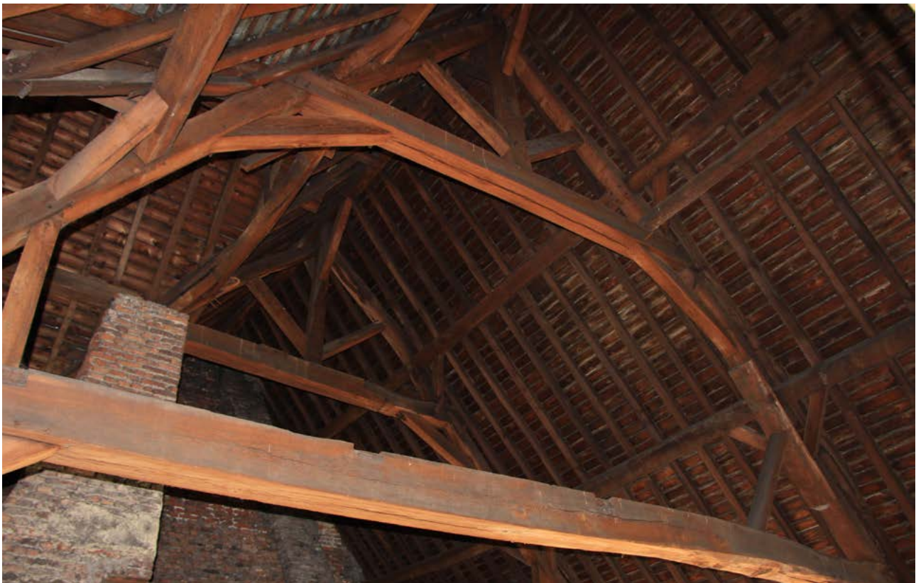
FIGURE 113 Charpente de l'aile occidentale : la photo illustre la ferme n°7 au premier plan (US.16), et la ferme n°8 (US.17) incomplète derrière. Photographie : M.Vanel, mai 2021.
