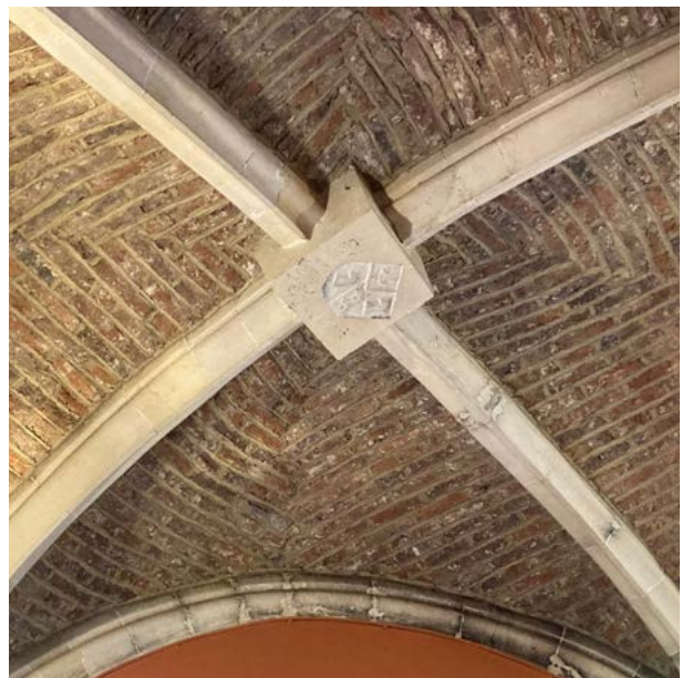
FIGURE 48 Le tuffeau employé pour les nervures des voûtes du cloître et de cet ancien passage vers les jardins. Photographies localisées sur le schéma ci-dessus : M. Vanel, juillet 2022.
