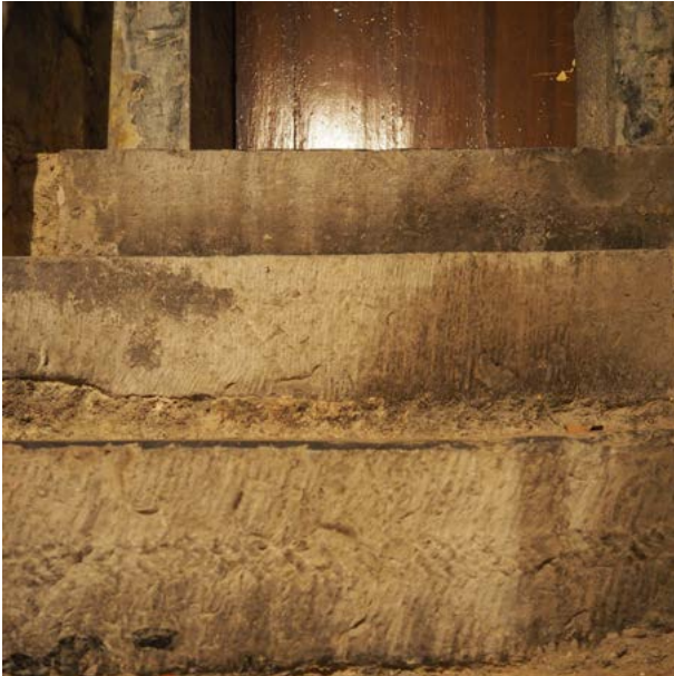
FIGURE 95 Escalier inférieur présentant différentes tailles de pierre d'une marche à l'autre. Photographie : M.Vanel, juillet 2020.
