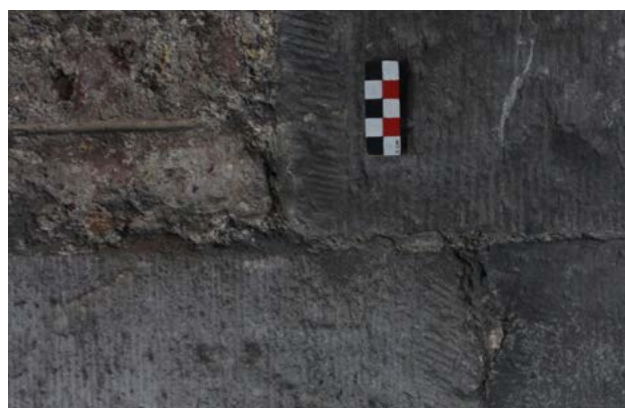
FIGURE 143 Détail des pierres d'encadrement de la baie (US.100) taillées au ciseau. Briques adjacentes avec joints tirés à la pointe. Photographie : M. Vanel, mai 2024.
