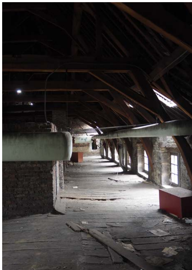
FIGURE 131 Rehausse de la salle de Justice dans le volume du comble. Photographie : M. Vanel, juin 2020.
