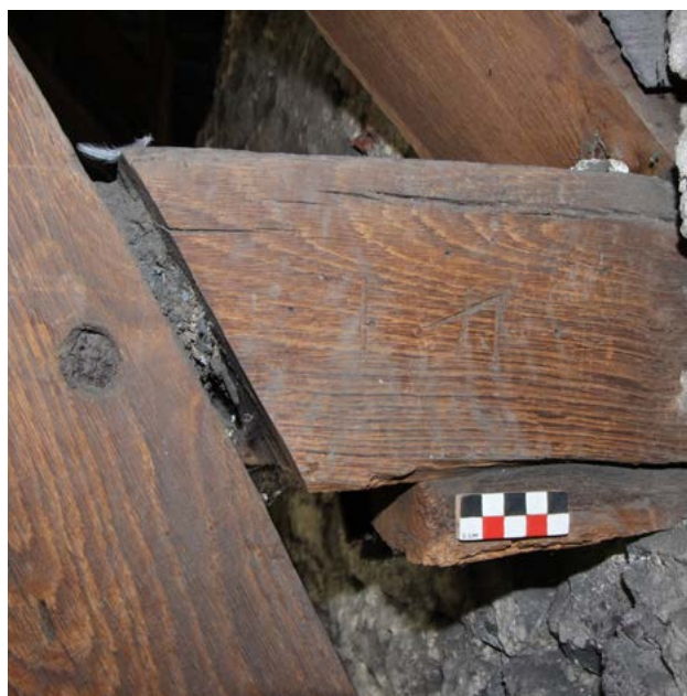
FIGURE 114 Marque de charpente repérée sur la face sud du blochet de la ferme n°7 (contre-marque | 11). Photographie : M.Vanel, mai 2024.
