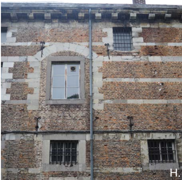
Grande baie surmontée d'un arc segmentaire en façade de l'aile méridionale, zone L.02/03, côté jardin.
