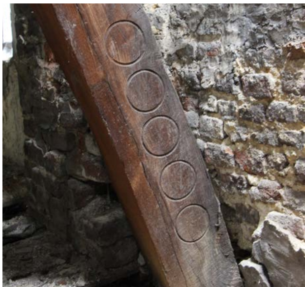
FIGURE 77 Marques circulaires relevées sur la jambe d'une ferme de l'aile orientale. Photographie : M. Vanel, mai 2024.
