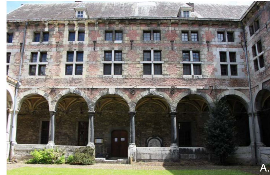
L'élévation de l'aile orientale, côté cloître, millésimée 1687.
