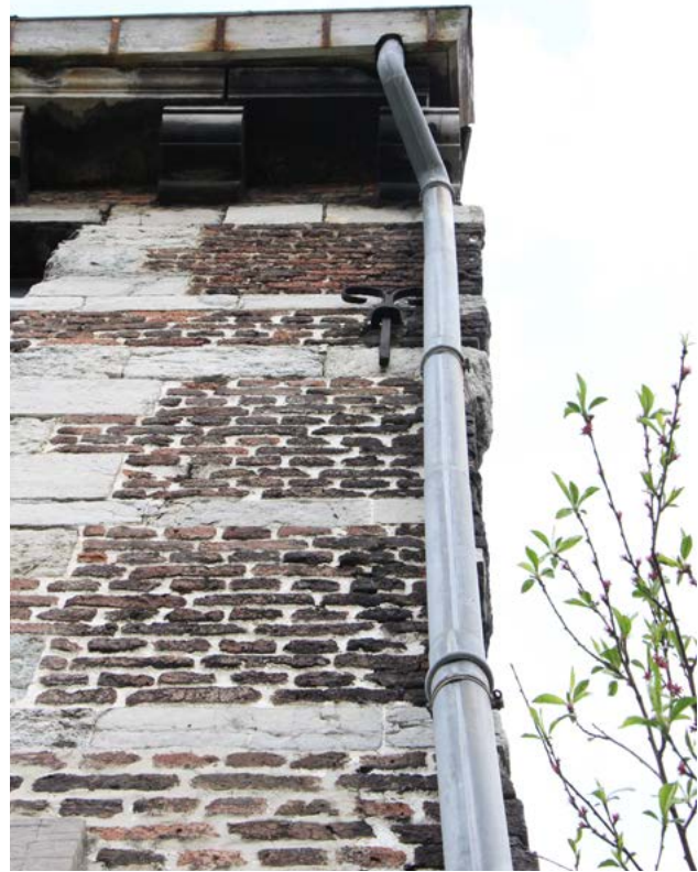
FIGURE 128 Extrémité sud de l'élévation de l'aile occidentale côté jardin. La maçonnerie mixte du mur dépasse du nu du pignon (US.41). Photographie : M. Vanel, juin 2022.
