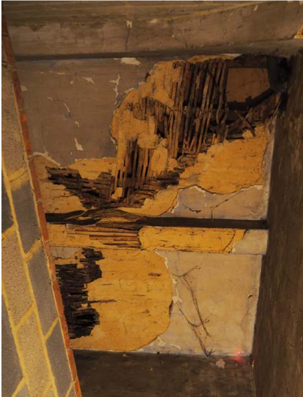
FIGURE 104 Plancher du couvrant rez (US.03) vue du dessous, le lattis de bois fortement remanié laisse percevoir un gîtage particulier. Photographie : M.Vanel., janvier 2022.
