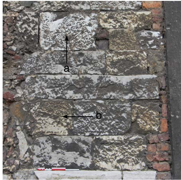
FIGURE 45 Façade nord du chevet de l'église : mise en œuvre simultanée du calcaire de 'type Meuse' (a) et de 'type Fort' (b). Photographies : M. Vanel, mai 2024.
