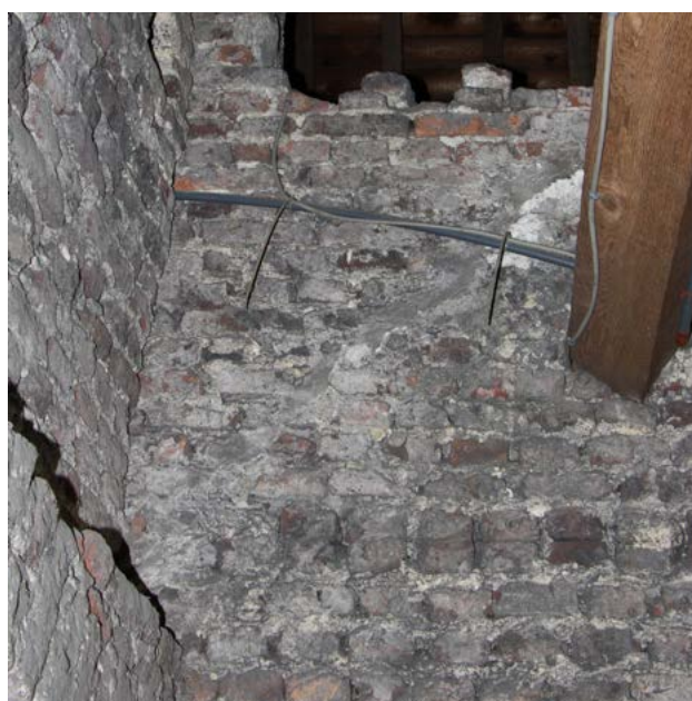
FIGURE 141 Trace d'un ancien solin de toiture (US.54). Photographie : M. Vanel, juillet 2022.
