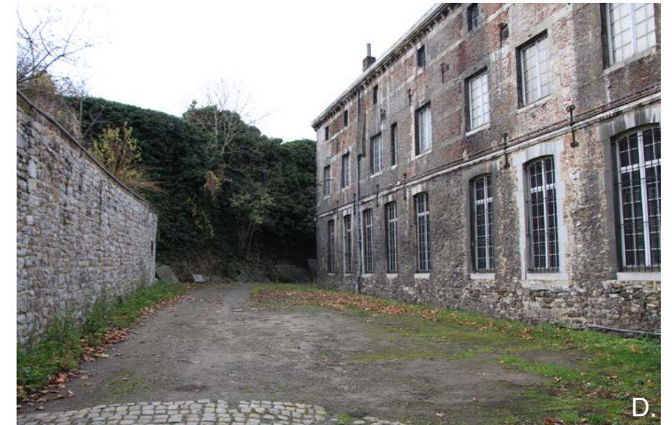
L'élévation de l'aile orientale, côté jardin.
