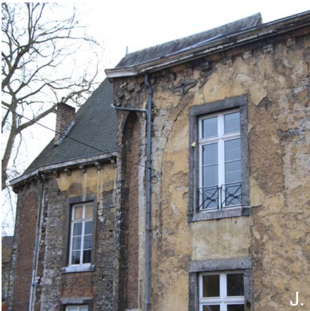
Sur la façade nord de l'église, les baies ogivales derrière l'enduit.
