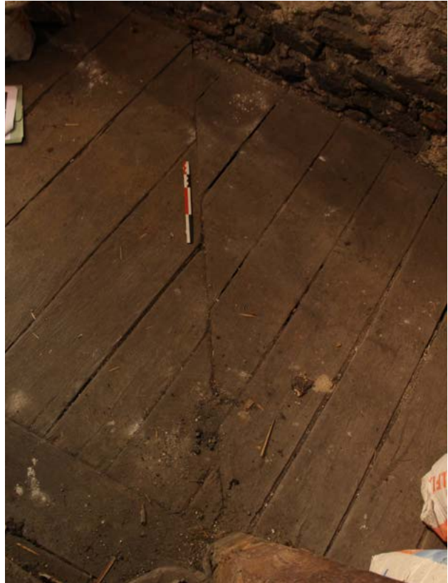
FIGURE 105 Plancher du couvrant rez (US.03) vue du dessus, la découpe oblique des planches de bois indique l'arrivée d'une ancienne volée. Photographie : M.Vanel, mai 2024.
