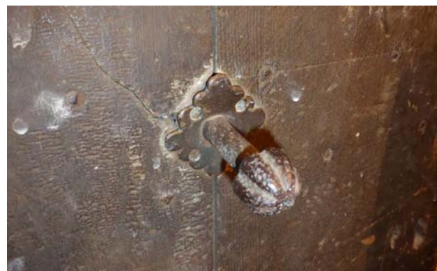
FIGURE 111 Détail de la poignée et de sa rosace de propreté. Photographie : J-L. Vanden Eynde, août 2022.
