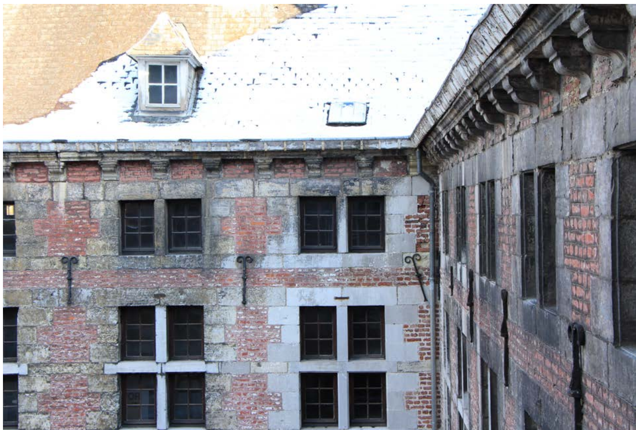
FIGURE 15 Cloître du couvent des Frères Mineurs de Huy - maçonnerie alternant briques et bandeaux de pierres calcaire de taille typique du Style Mosan. Photographie : M. Vanel, juillet 2021.
