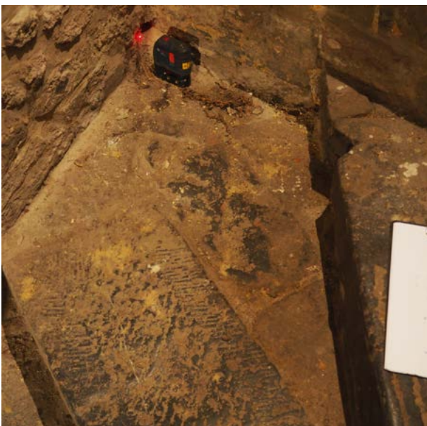
FIGURE 96 Escalier inférieur, quatrième marche, un exemple où la pierre calcaire taillée au ciseau en périphérie n'est pas ajustée à la marche. Photographie : M.Vanel, juillet 2020.
