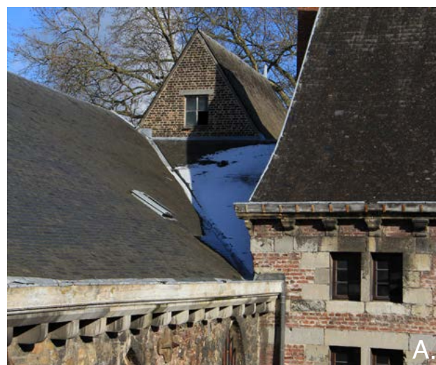
FIGURE 26 Désaxement des bâtières couvrant la nef et le chœur. Photographie : M. Vanel, février 2021.
