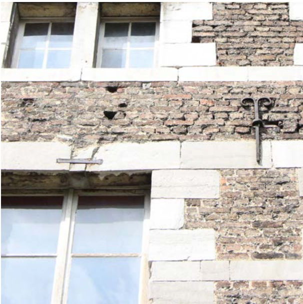
FIGURE 51 Ancre et agrafe en fer forgé. Photographie : M. Vanel, juin 2022.
