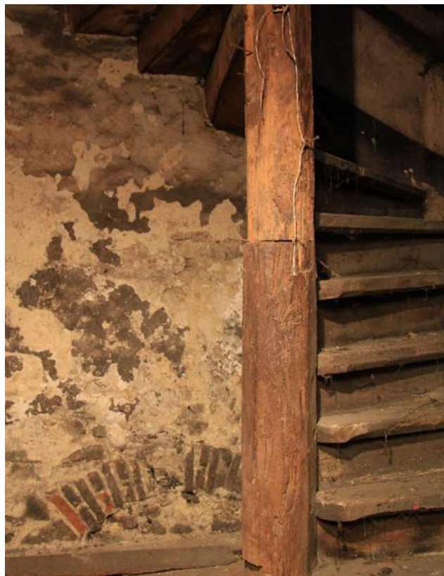
FIGURE 84 Escalier en bois à l'étage de la zone d'étude choisie. L'approche archéologique s'applique à décrire les unités que sont par exemple l'escalier et ses assemblages ou l'arc en brique visible en partie basse du mur, à l'arrière plan. Photographie : M. Vanel, décembre 2020.
