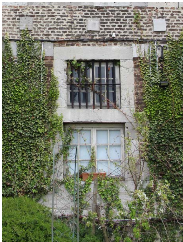
FIGURE 134 Baie bipartite du rez-de-chaussée de l'aile occidentale, côté jardin. Photographie : M. Vanel, juin 2022.
