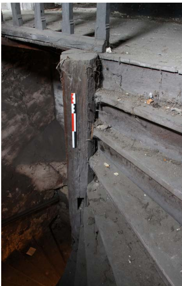
FIGURE 100 Escalier supérieur en bois. Le noyau semble avoir été recoupé au niveau du plancher des combles. On remarque une mortaise au niveau de la 15 e marche, sans raison d'être. Photographie : M.Vanel, mai 2024.
