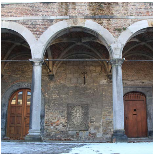
FIGURE 158 Partie du mur goutterau de l'église abritée par le portique d'entrée de l'ancien couvent. Photographie : M.Vanel, février 2021.
