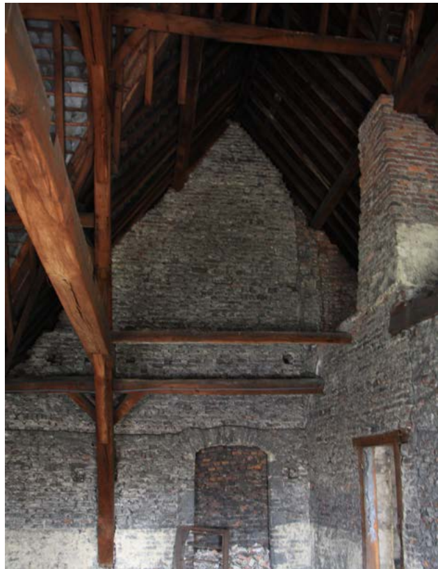
FIGURE 115 Intersection entre les charpente occidentale et méridionale. Le chevronnage de la charpente occidentale a été recoupé, la panne ventrière intermédiaire et son aisselier démontés. Photographie : M.Vanel, mai 2021.
