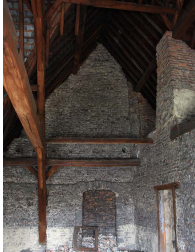
FIGURE 137 Pignon intérieur entre les ailes occidentale et méridionale, en maçonnerie à épaisseur variable (US.49 et 50). Réservations du gîteage d'un ancien plancher au-dessus (US.52). Photographie : M. Vanel, mai 2021.
