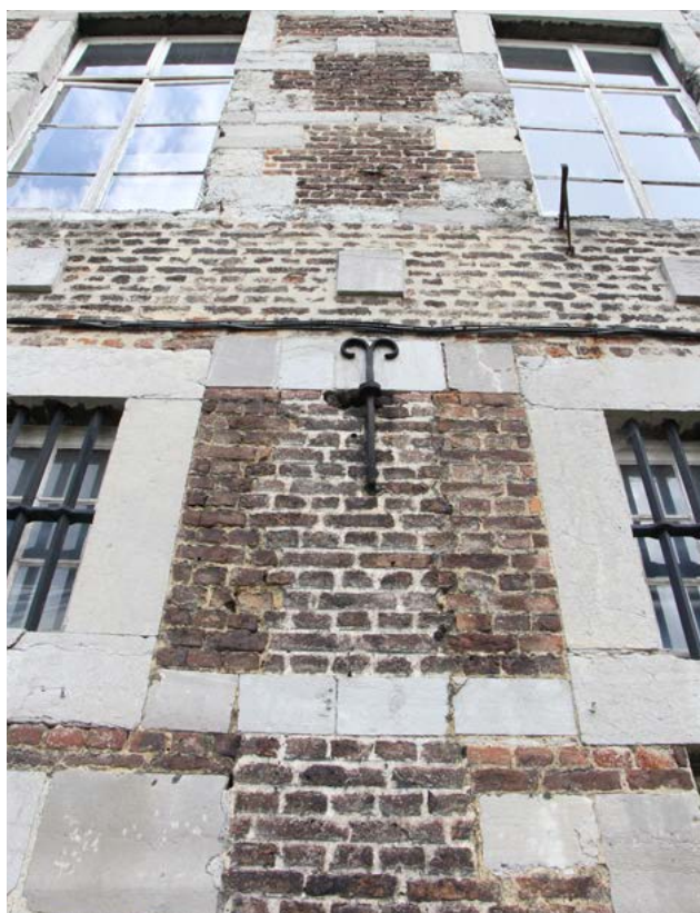
FIGURE 135 Entre 2 baies de l'aile occidentale, on perçoit le raccord entre les maçonneries de brique. Photographie : M. Vanel, juin 2022.
