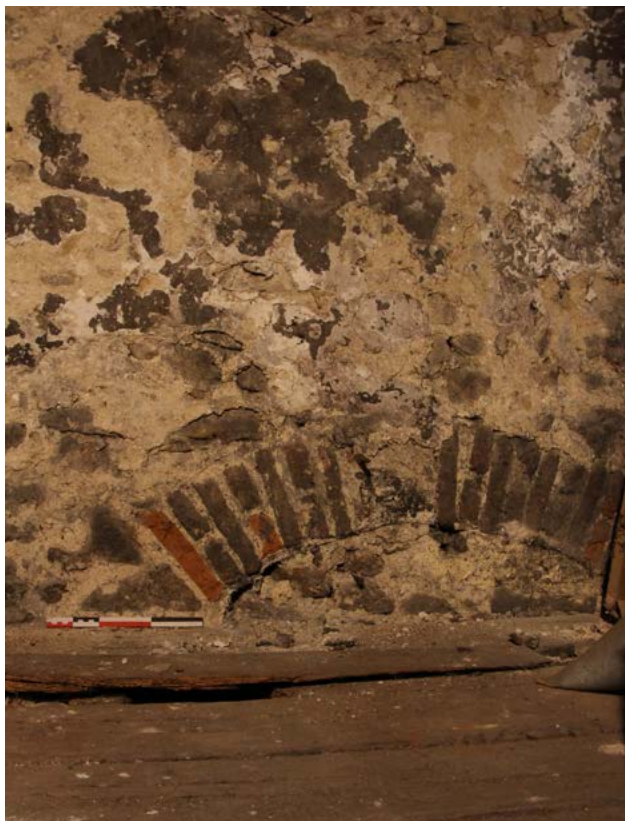
FIGURE 106 Sur le mur M.03/04.00.01, baie murée (US.05). Photographie : M.Vanel, mai 2024.
