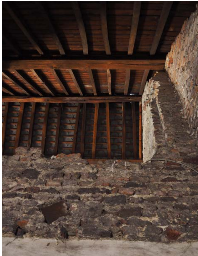
FIGURE 110 Trace d'une ancienne battée de porte (US.14) au niveau du mur M.03/04.+2.05. Photographie : M.Vanel, juillet 2020.
