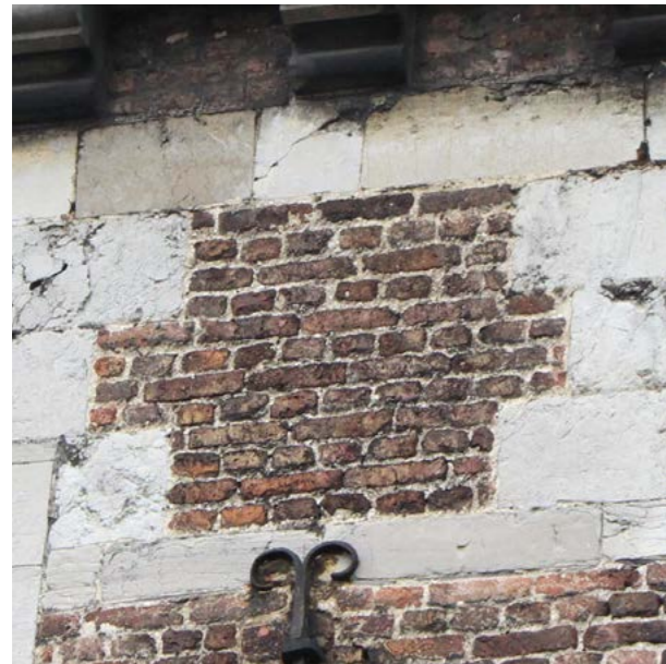
Maçonnerie en brique de type A
