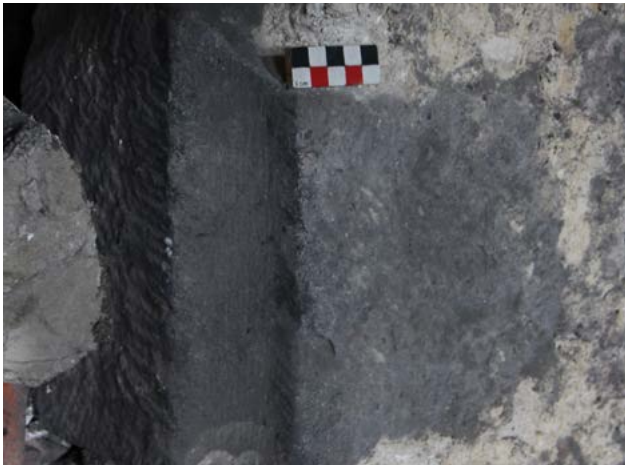
FIGURE 138 Détail du piédroit de la porte murée (US.51), avec une pierre calcaire à l'angle profilé en cavet. Photographie : M. Vanel, mai 2024.
