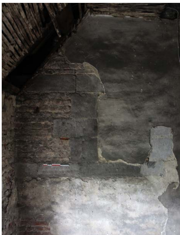
FIGURE 142 Derrière l'enduit, une ancienne façade de la tourelle d'escalier apparaît avec une petite fenêtre (US.56) et les bandeaux de pierre calcaire (US.55). Remplissage en brique à joints tirés à la pointe. Photographie : M. Vanel, mai 2024.
