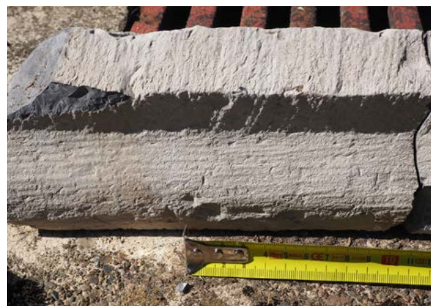
FIGURE 122 Éléments de la corniche sud de l'aile méridionale en pierre calcaire, taille fine au ciseau. Photographie : M.Vanel, juillet 2020.
