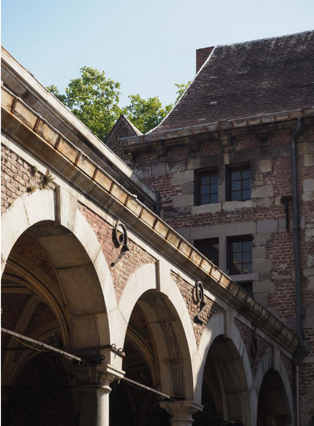
FIGURE 42 Élévation de l'angle nord-est du cloître : la brique, la pierre, le bois, le fer et l'ardoise sont mis en œuvre conjointement. Photographie : M. Vanel, juillet 2020.
