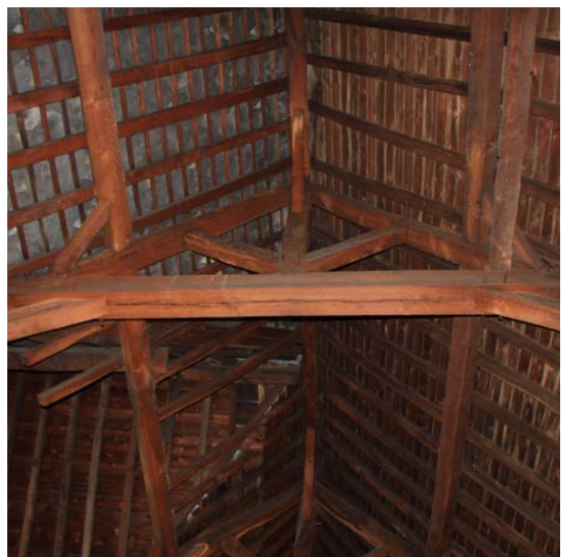
FIGURE 50 Charpente en bois de chêne de l'aile occidentale. On note la présence d'un voligeage sur le pan occidentale, celui côté cloître n'en présentant pas.
