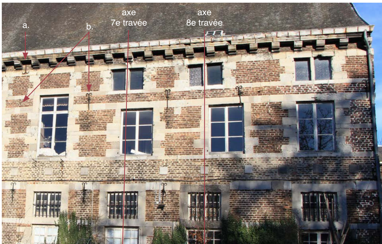
FIGURE 132 En (a), la position des ancres après rehaussement de la salle de Justice et des baies qui l'éclairent. En (b), la position des ancres avant modification. Photographie : M. Vanel, mars 2021.
