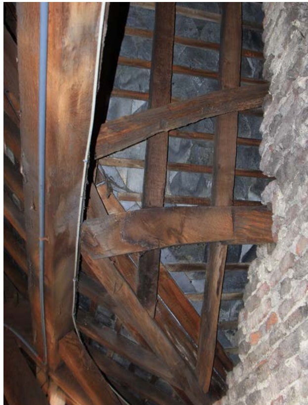
FIGURE 116 Intersection entre les charpente occidentale et méridionale. Des éléments de réemploi sont utilisés pour compléter la charpente. Photographie : M.Vanel, mai 2021.
