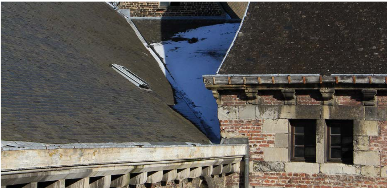
FIGURE 53 Couvertures en ardoises naturelles. A gauche, celle de l'église au clou, à droite, celle de l'aile orientale, au crochet. Photographies localisées sur le schéma ci-dessus : M. Vanel, février 2021.
