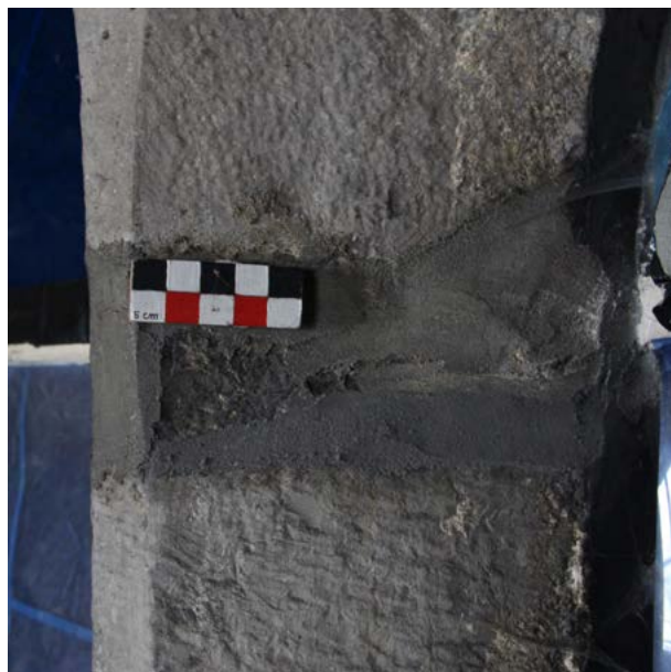
FIGURE 65 En dessous de la mire, taille au ciseau sur les 4 meneaux gauche de la baie #C. Au-dessus, taille du réseau au ciseau grain d'orge.
