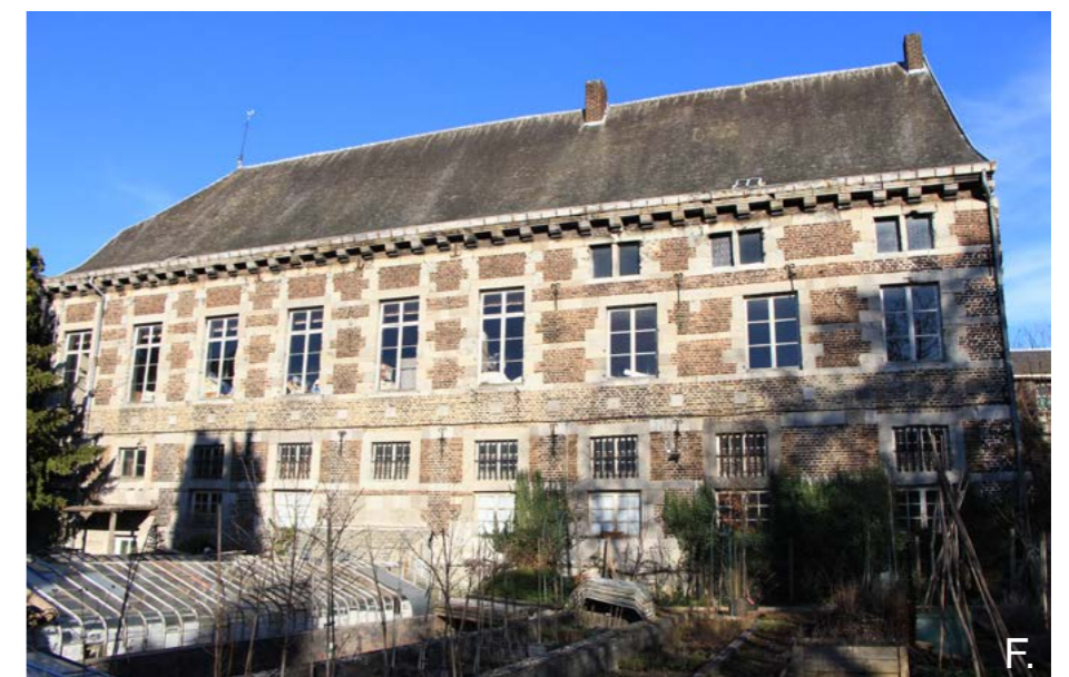
L'élévation de l'aile occidentale, côté jardin.
