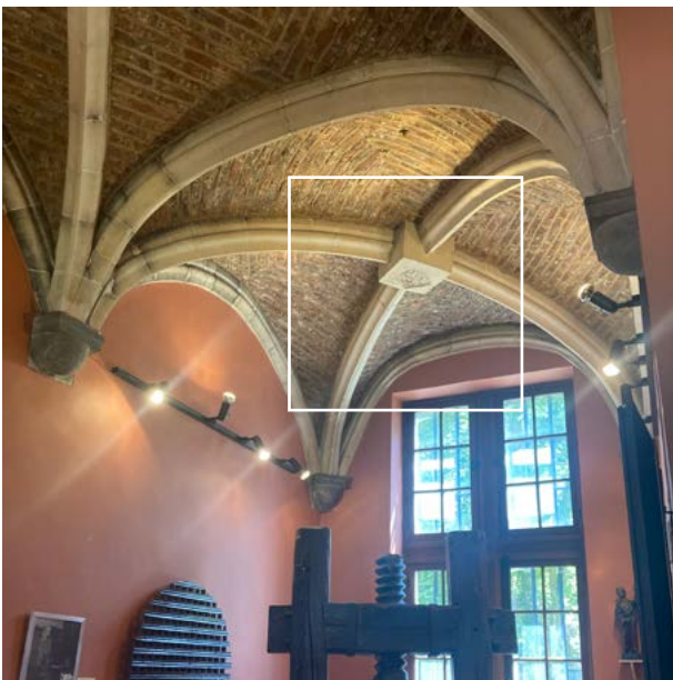
FIGURE 48 Le tuffeau employé pour les nervures des voûtes du cloître et de cet ancien passage vers les jardins. Photographies localisées sur le schéma ci-dessus : M. Vanel, juillet 2022.
