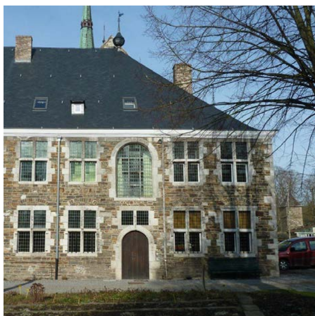
FIGURE 161 Abbaye de Val-Dieu, l'élévation de l'aile méridionale présente une grande baie comparable à celle de Huy. Photographie : X. Tonon
