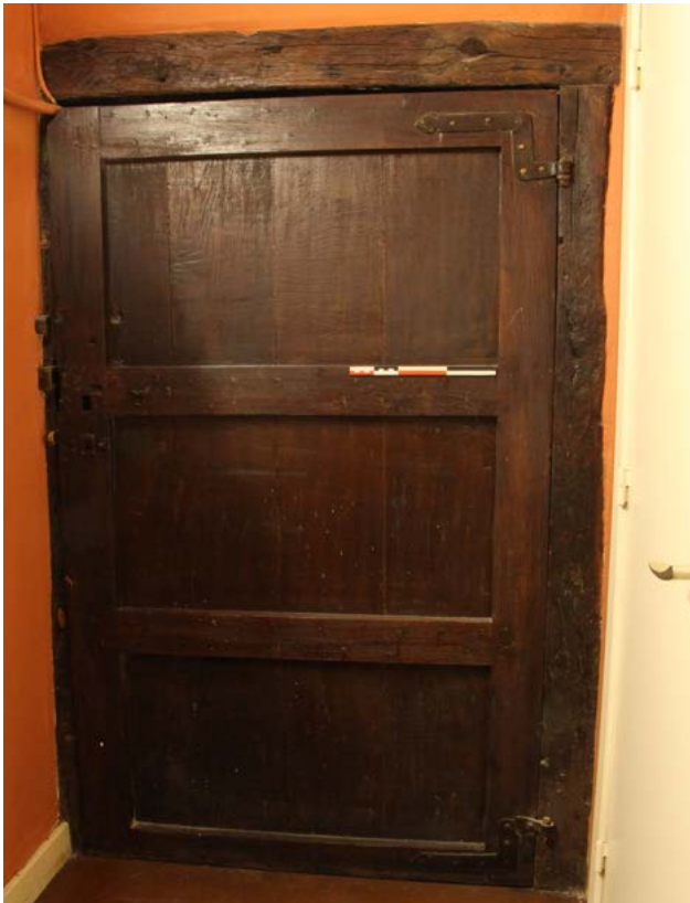
FIGURE 109 Porte en bois (US.12) menant à la cage d'escalier supérieure. Photographie : M.Vanel, mai 2024.
