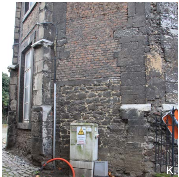
Sur la façade de l'abside du chœur, des contreforts partiellement visibles.
