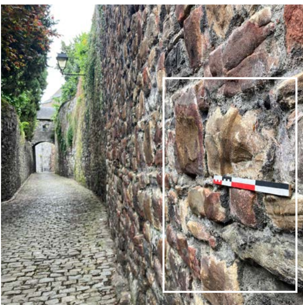
FIGURE 44 Mur de soutènement du site depuis la ruelle des Frères Mineurs : on remarque le poudingue (a) et le schiste lie-de-vin (b) mis en œuvre conjointement. Photographies localisées sur le schéma ci-dessus : M. Vanel, juillet 2021 et mai 2024.
