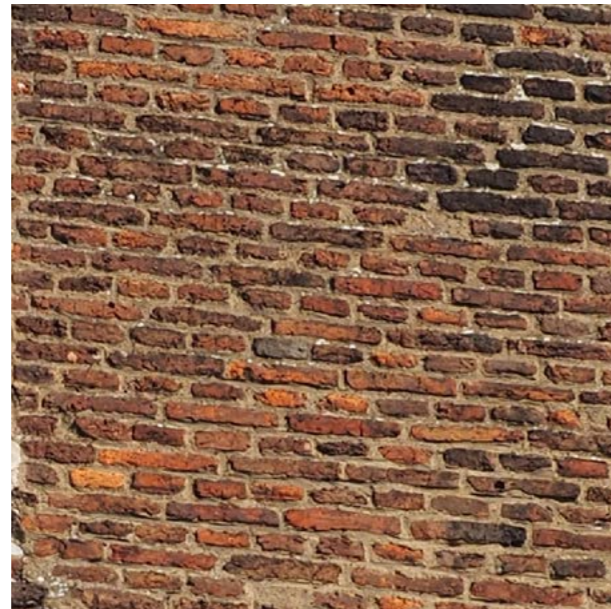
Maçonnerie en brique de type B
