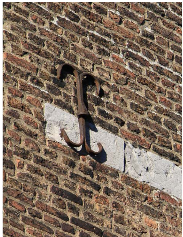
FIGURE 125 Ancre en X observée sur l'élévation sud de la tourelle d'escalier (US.38), au dessus du bandeau (US.37) surmontant la baie (US.07). Photographie : M. Vanel, mars 2021.
