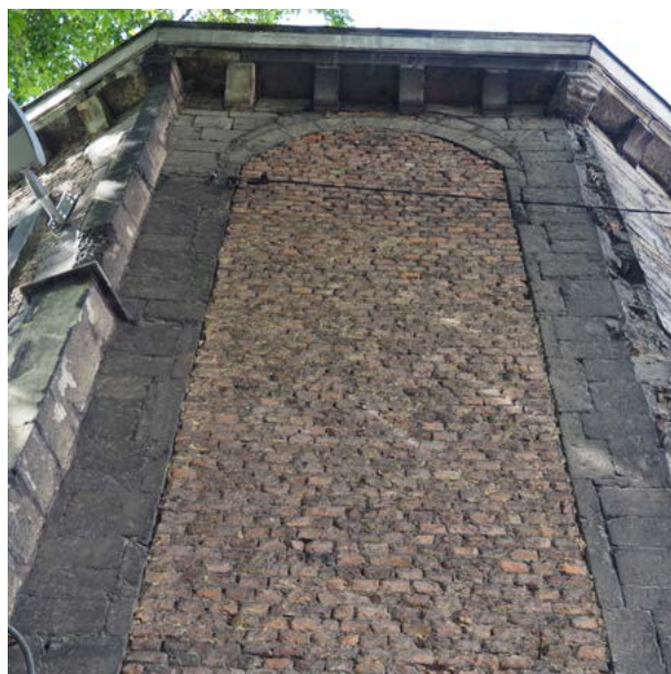
FIGURE 69 Chevet du chœur - observation d'un double arc.
