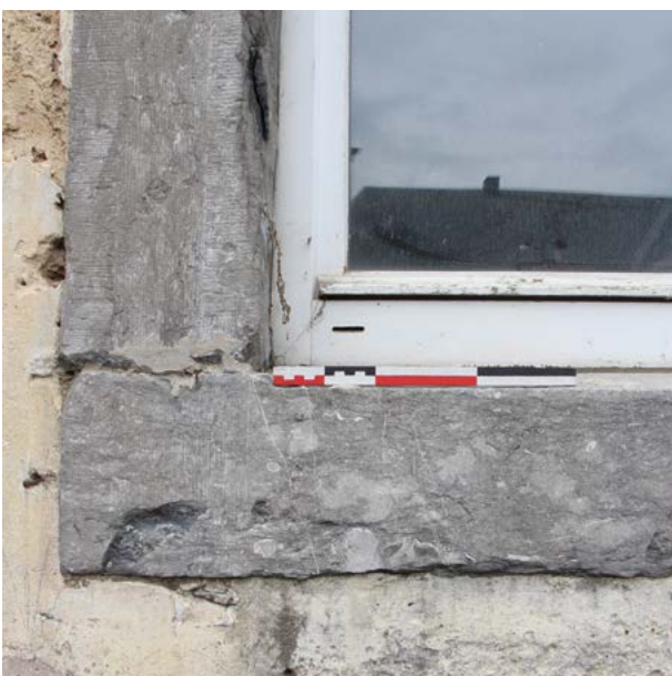
FIGURE 46 Petit granit du Bocq utilisé pour l'encadrement de la baie. Photographies localisées sur le schéma ci-dessus : M. Vanel, mai 2024.
