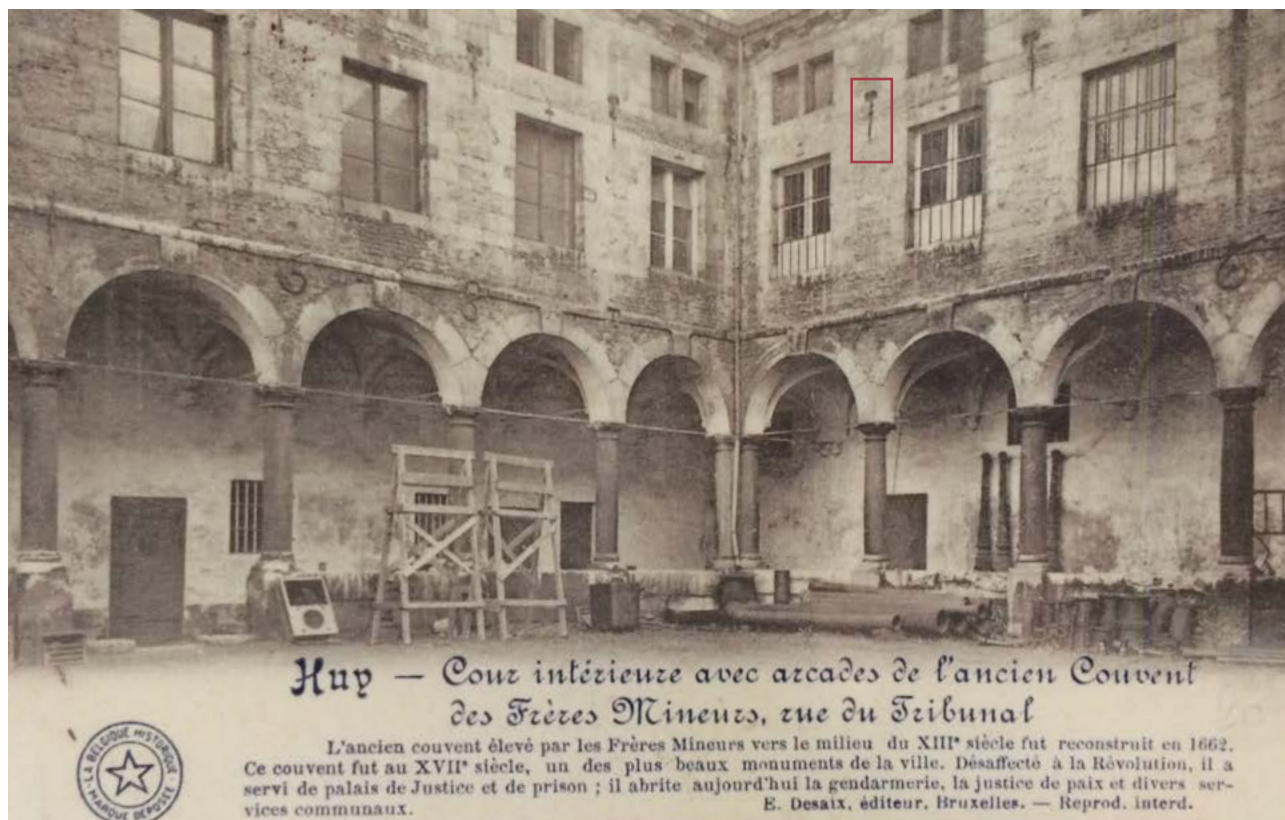
FIGURE 137 Carte postale non datée présentant une photo de l'angle sud-est du cloître prise avant la restauration du début XX e siècle. Dans le cadre, une ancre de type 5 est repérée, plus tard remplacée par une ancre de type 9. Consultée au musée communal, Huy.
