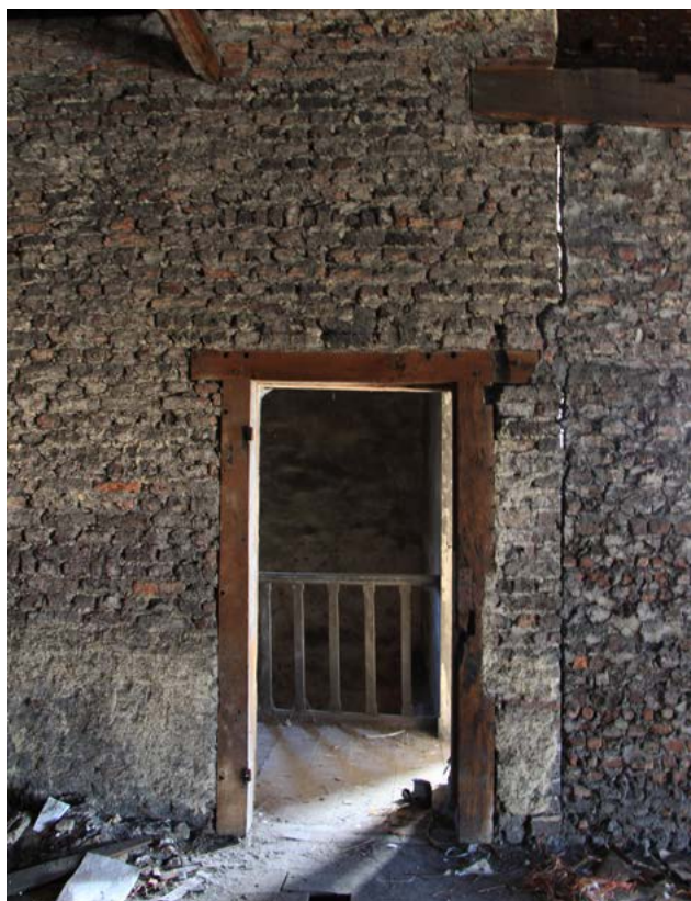
FIGURE 140 Porte avec encadrement en bois de réemploi (US.13). Photographie : M. Vanel, mars 2021.
