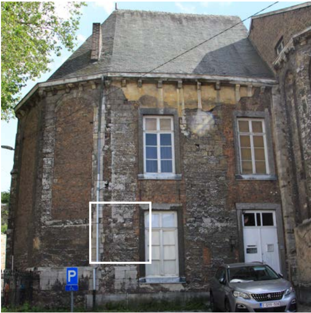
FIGURE 45 Façade nord du chevet de l'église : mise en œuvre simultanée du calcaire de 'type Meuse' (a) et de 'type Fort' (b). Photographies : M. Vanel, mai 2024.
