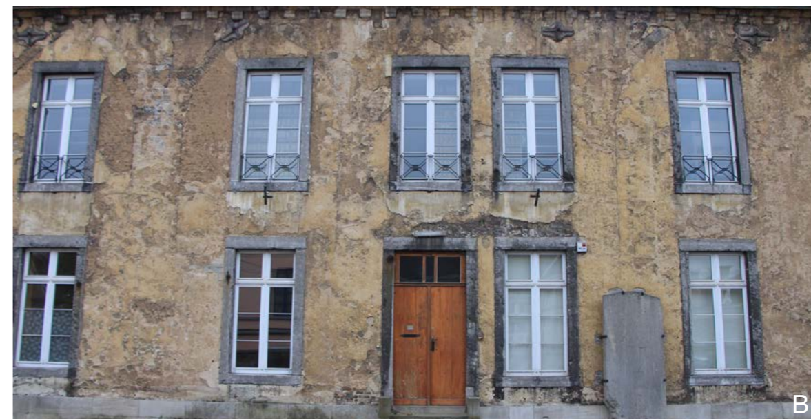
L'élévation nord de l'ancienne église, côté parking et rue Vankeerberghen, décembre 2020.
