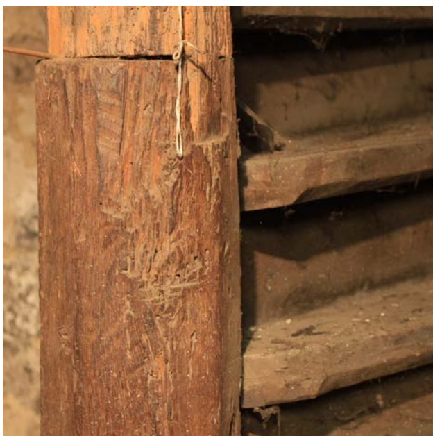
FIGURE 99 Escalier supérieur, détail de l'assemblage des deux parties du noyau par enture à enfourchement. Photographie : M.Vanel, décembre 2020.
