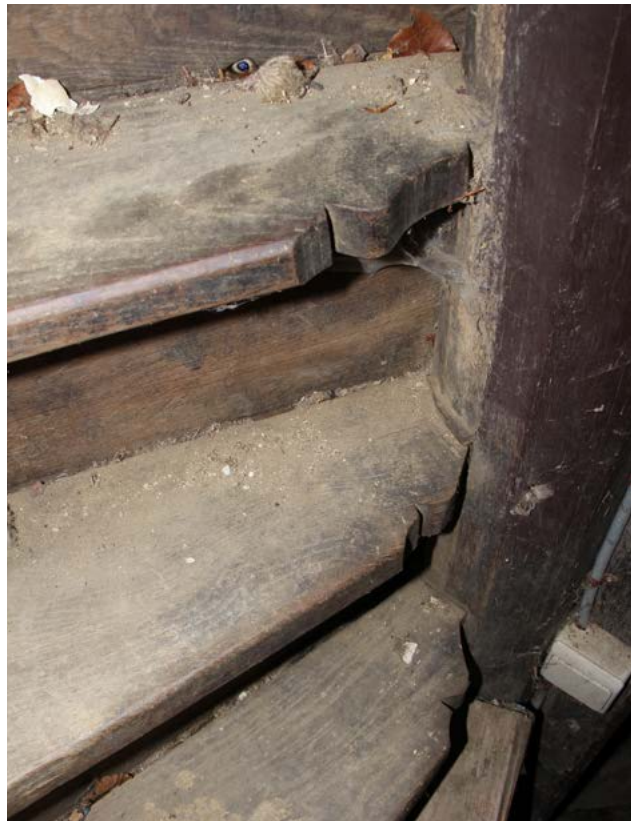
FIGURE 101 Escalier relevé dans une ferme à pan-de-bois à Exbomont. Il est comparable à celui du couvent de Huy du point de vue des éléments qui le constituent et de leur assemblage. La finition des marches et du noyau est cependant plus soignée. Schéma : Nancy Verstraelen - Photographie : M.Vanel, août 2022.
