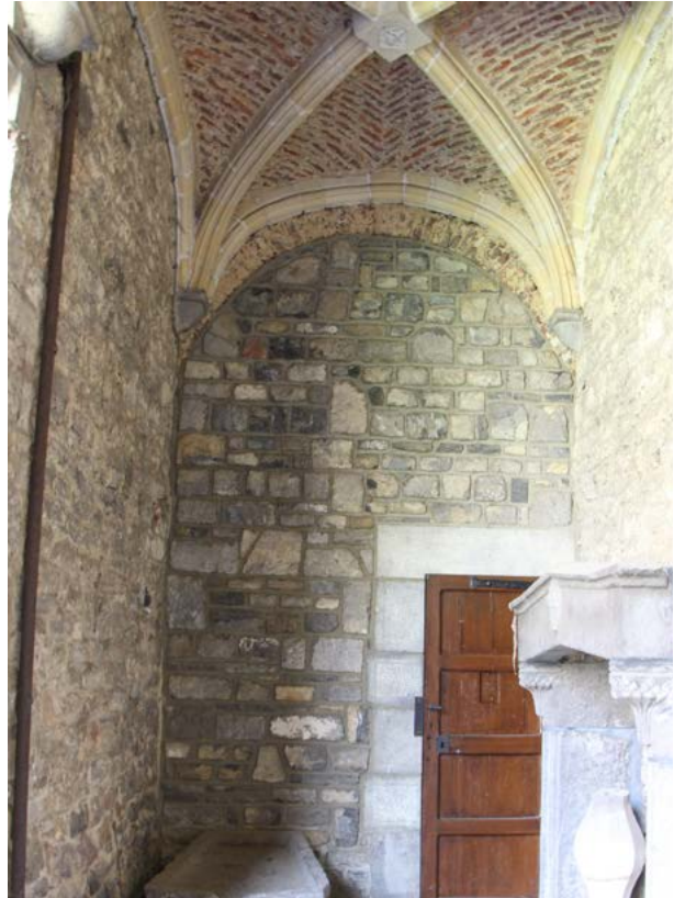
FIGURE 108 Mur M.03/04.00.04 : La dernière arcade de la galerie du cloître est murée par une maçonnerie mise en œuvre récemment (US.09 à 11). Photographie : M.Vanel, juillet 2022.
