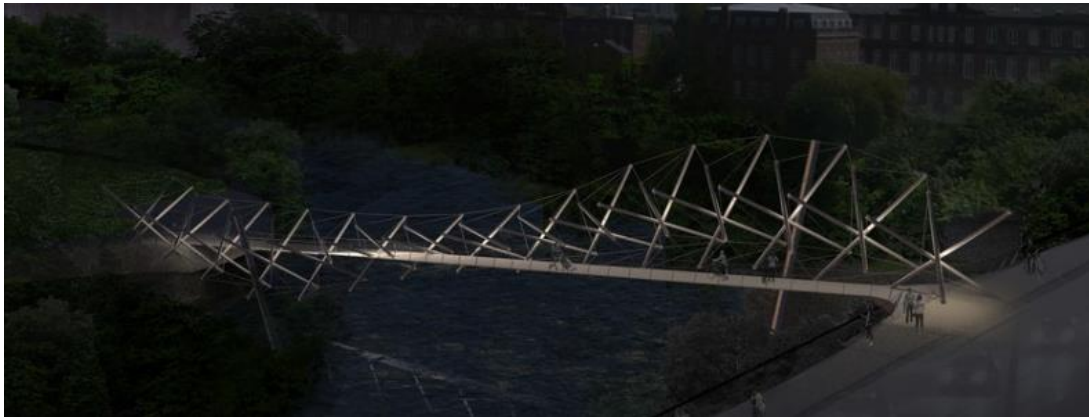
FIGURE 1.19 – Projet de passerelle de tenségrité Meadows bridge [16]
