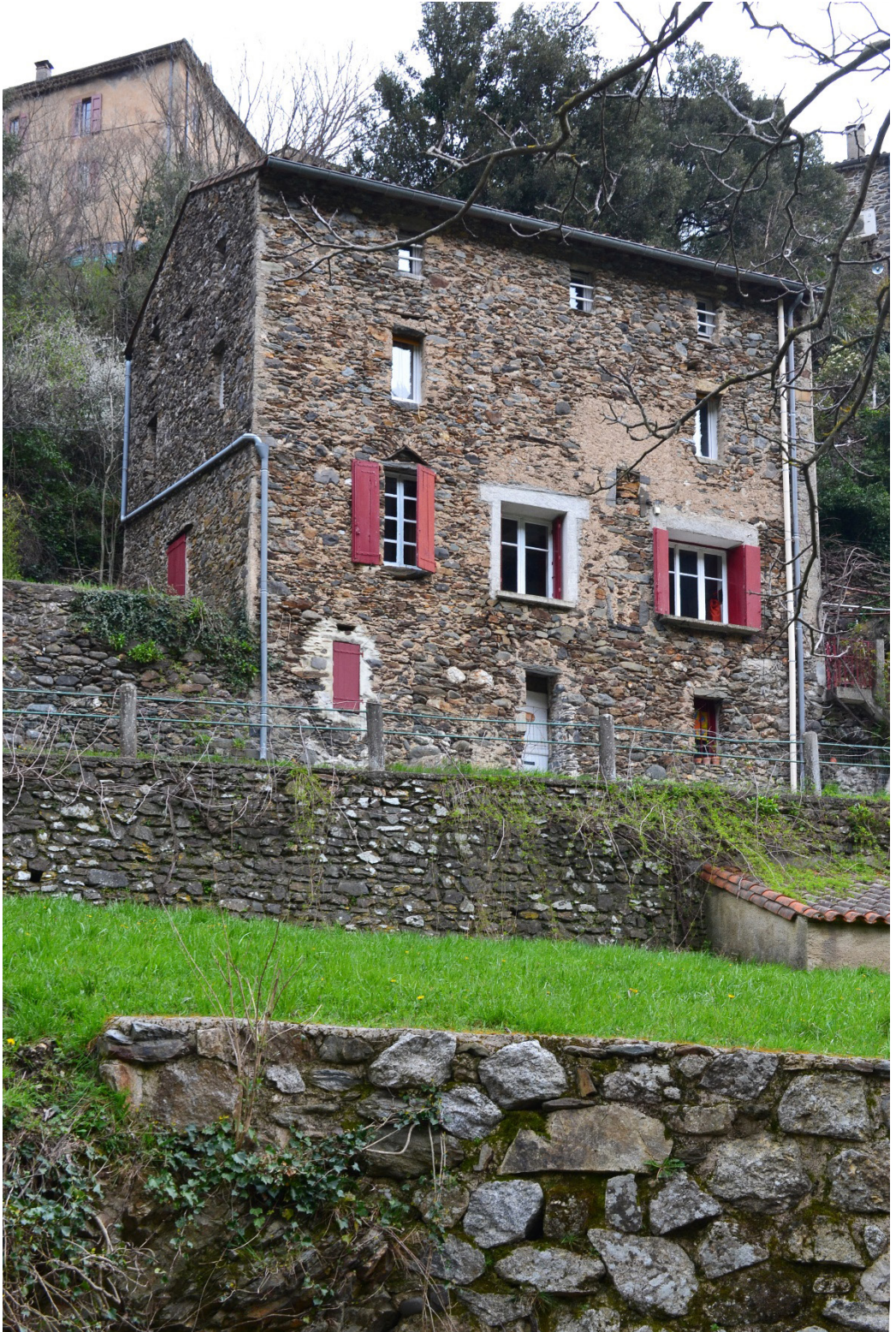
La Maison familiale dont les remaniements sont visibles, Hameau des Salles, Photo : P.Boonaert mars 2021
