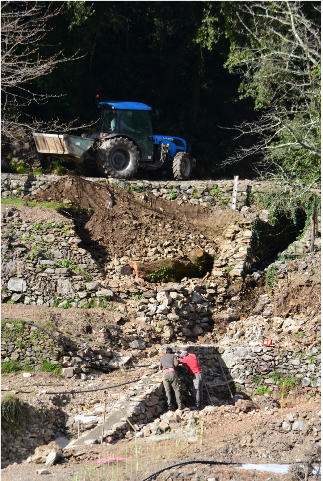
Un tancat en cours de restauration, cinq mois après les inondations il reste beaucoup de constructions à réparer..., Photo : P.Boonaert mars 2021
