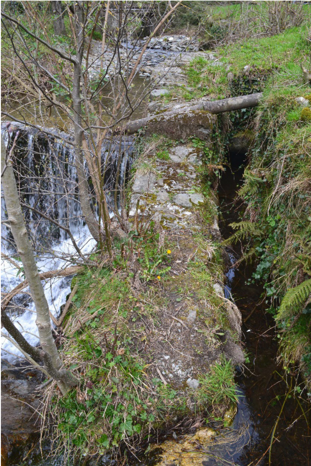
Vue de la prise d'eau d'un béal sur une paissière, affluent du Clarou, Photo : P.Boonaert mars 2021
