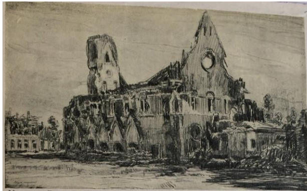
Nieuport : Ruine des Halles, le 7 Septembre, 1916. Par M. Wagemans.
