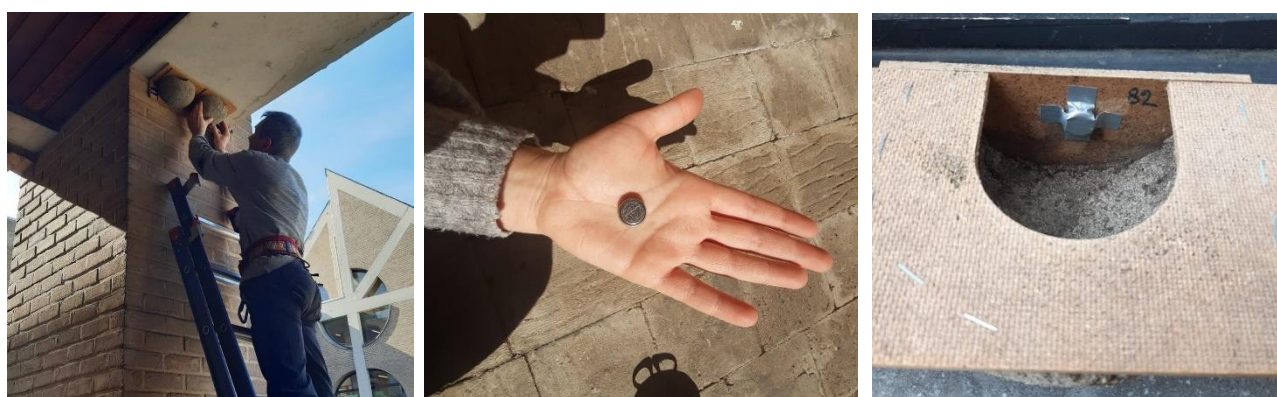
Figure 17 : Photographies prises pendant l'installation des capteurs thermiques dans les nids artificiels d'Hirondelles de fenêtre à Louvain-la-Neuve. L'image de gauche illustre comment les nids sont décrochés à l'aide d'une échelle. Sur l'image du centre un capteur thermique iButton est montré. L'image de droite illustre la méthode de fixation et la position des capteurs dans les nids.
