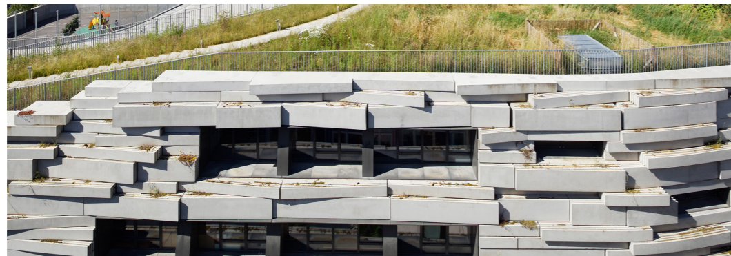
Fig. 31 : Façade texturée en éléments préfabriqués - ChartierDalix (Firm), « Recherche : Accueillir le vivant - ChartierDalix », Chartier-Dalix, consulté le 31 mai 2023, https://www.chartier-dalix.com/fr/ressources/accueillir-vivant-recherche .
