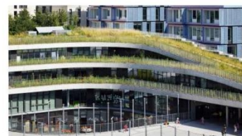
Figure 17 – Photographie : toitures végétales [18].
