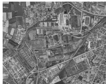
Figure 19 – Photographie : zone de la Courrouze 1950 [21].
