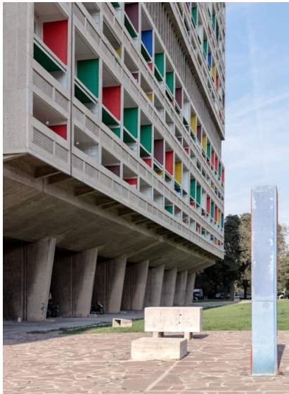
Figure 62 : Photographie « l'Unité d'Habitation de Le Corbusier »
