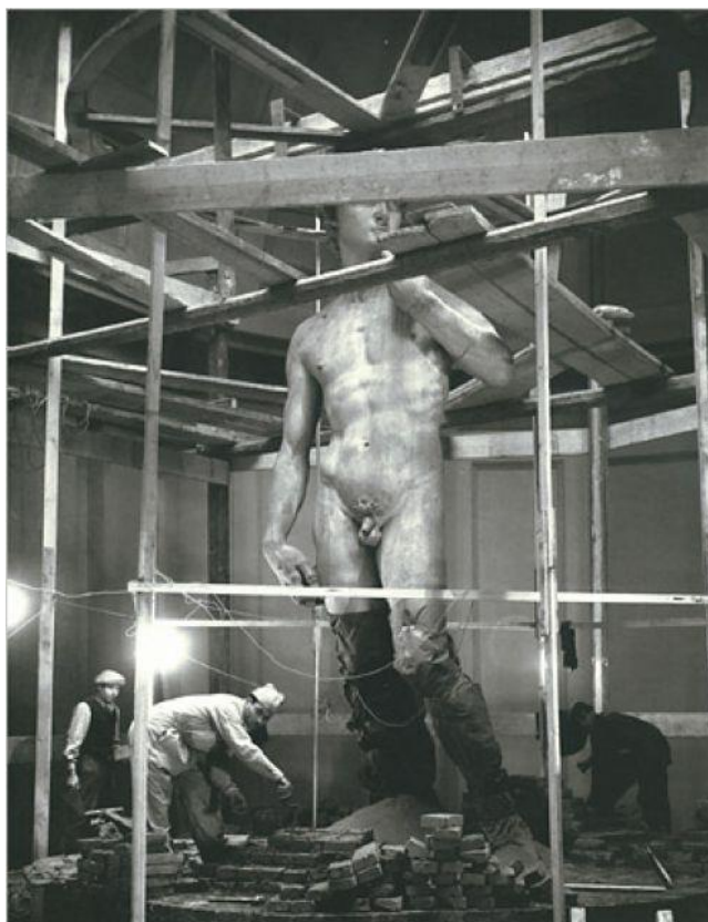
Fig. 16. Auteur Inconnu, Protection du David de Michel Ange , 1940 – 1945. Photographie, s. d., Cabinet photographique du musée florentin.
