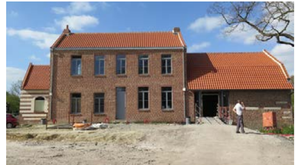
Fig 9 : La ferme du Bocquiau en cours de transformation
