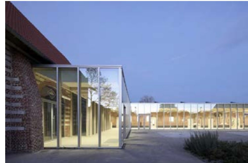
Fig 12 : Photographie de l'intérieur de la cour du centre culturel, projet achevé
