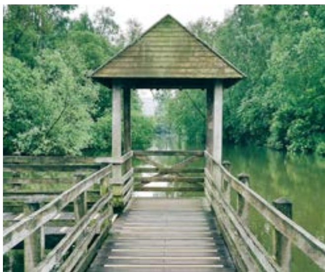
Fig 32 : Photographie d'un ponton du parc de la Deule
