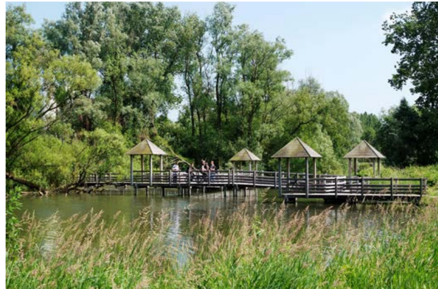
Fig 18 : Ponton en bois aménagé - Parc de la Deûle - Wavrin
