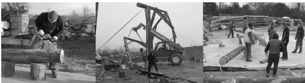
Figure 2-4 photos hangar auto-construit en grumes, https://www.latelierpaysan.org/
