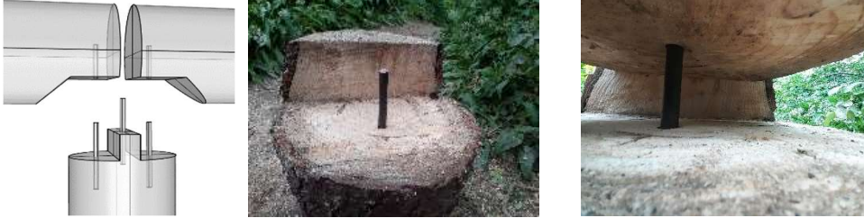
Figure 9-3 photos assemblage avec broche
